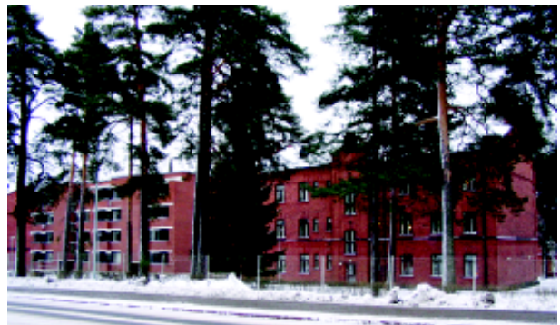
Kuva 20. 1910- ja 1970-luvulla rakennettuja kasarmeja. Henrik Wager 2005.
