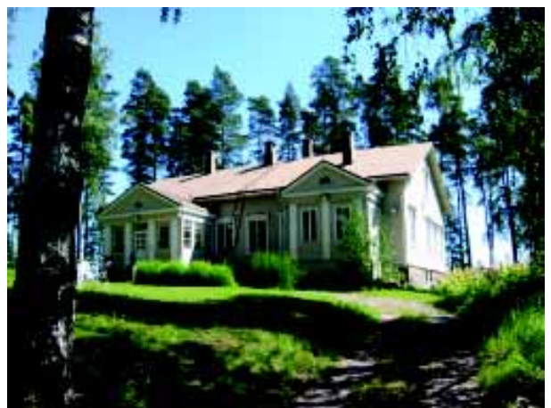
Kuva 8. Vilppulan päärakennus. Teija Ahola 2003.
