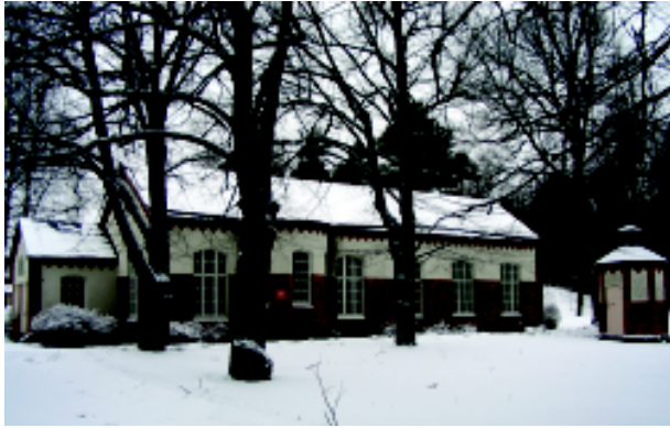
Kuva 32. Lahden pumppuasema. Henrik Wager 2005.
