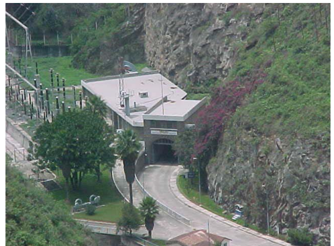
Casa de máquinas
