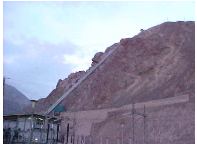
Casa de máquinas y tubería de presión
