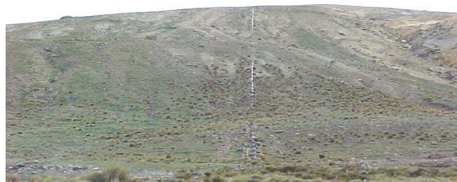
Tubería de Presión
