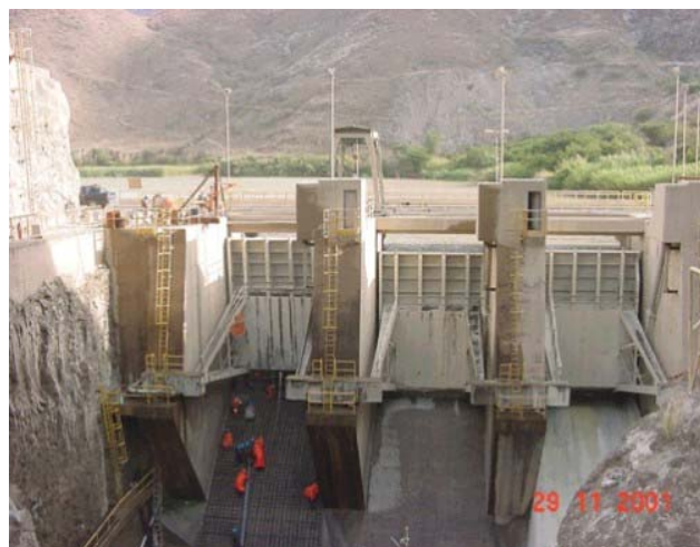
Presas – compuertas reguladoras
