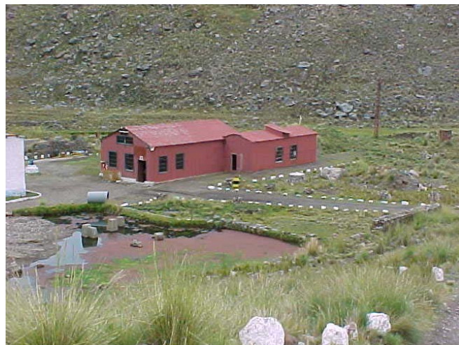
Casa de máquinas
