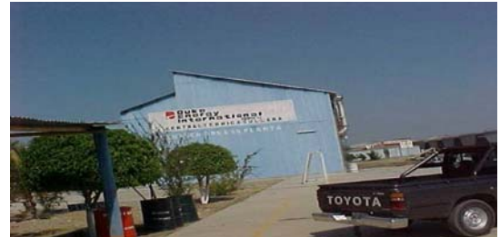
Casa de máquinas
