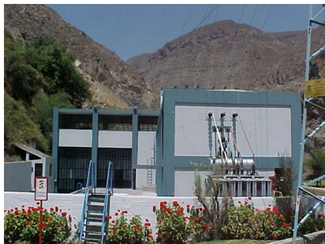
Casa de máquinas
