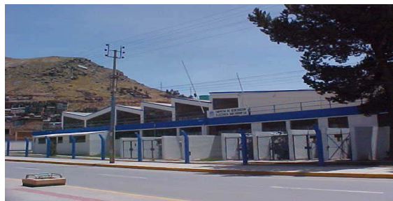
Casa de máquinas
