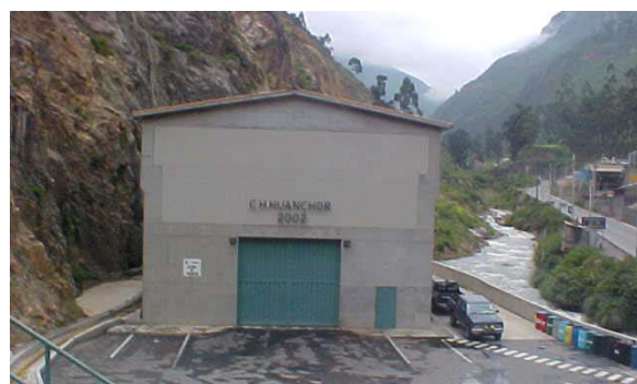
Exterior de casa de máquinas
