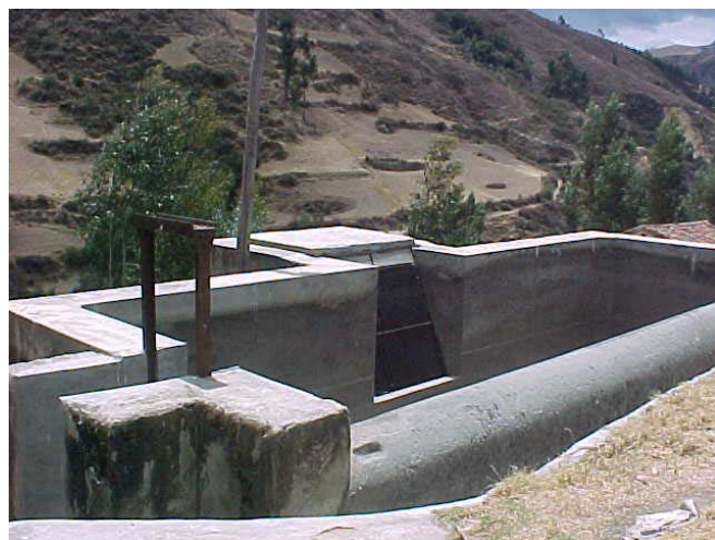
Cámara de carga
