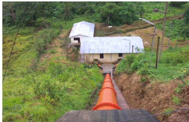
Casa de máquinas y tubería de presión
