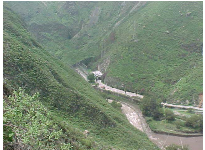
Ingreso a casa de máquinas
