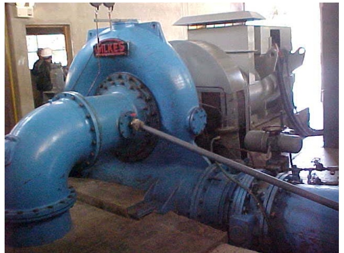
Turbina Francis - Eje horizontal
