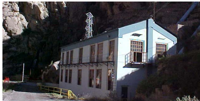
Casa de máquinas
