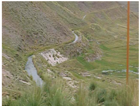
Canal de aducción
