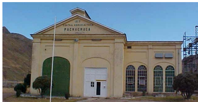
Casa de máquinas
