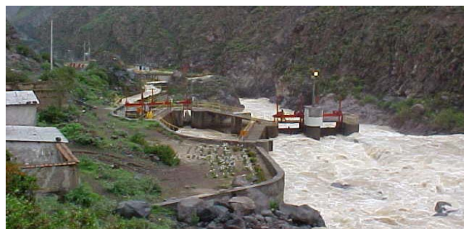
Bocatoma - río Chili
