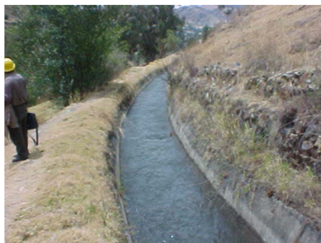
Canal de Aducción
