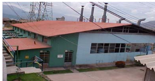
Casa de maquinas
