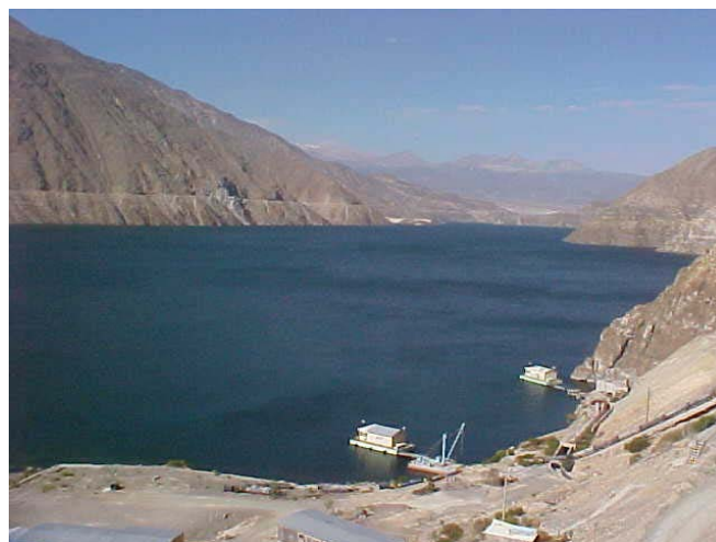
Laguna Aricota – caseta de bombeo
