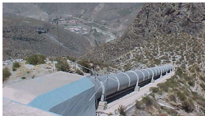
Tubería de presión
