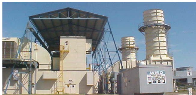
Casa de máquinas
