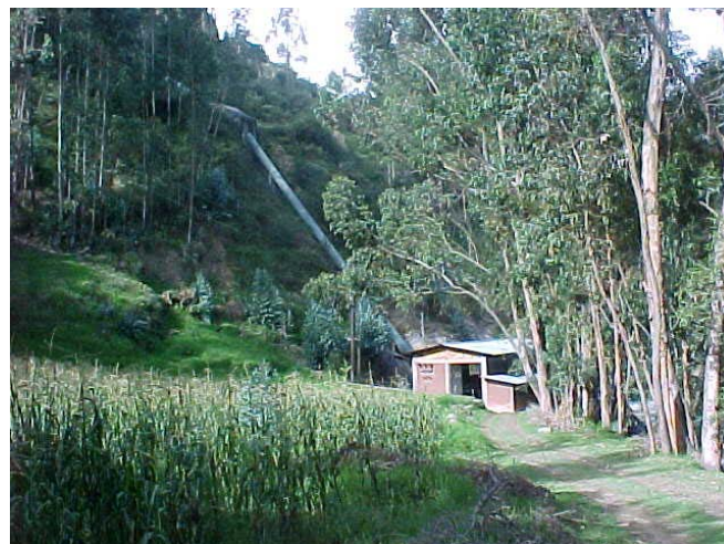
Casa de Máquinas
