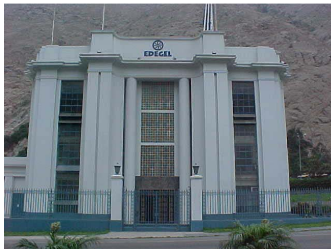
Casa de máquinas
