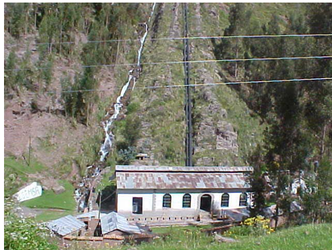
Casa de máquinas
