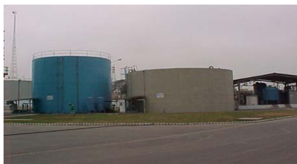
Tanques de agua y planta de tratamiento
