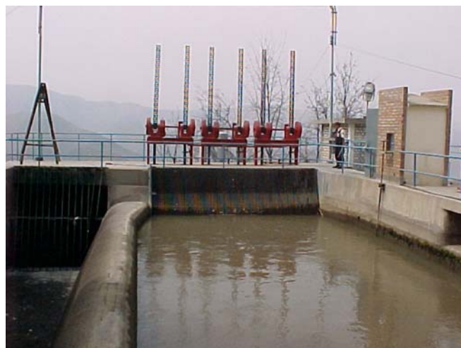
Cámara de carga
