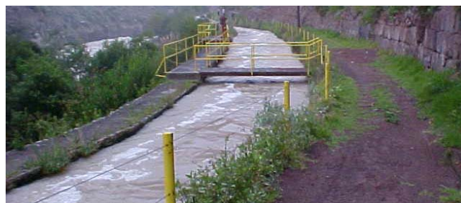
Canal de aducción
