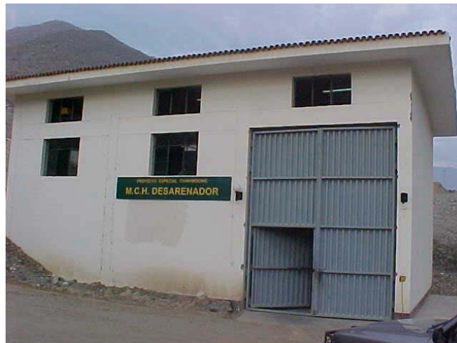
Casa de máquinas
