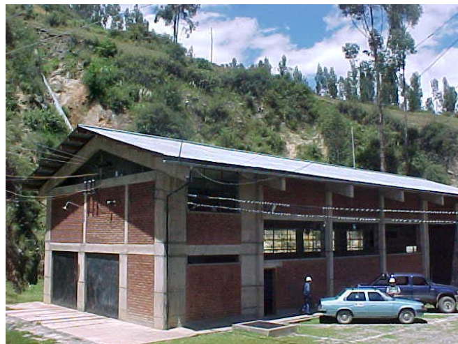
Casa de máquinas
