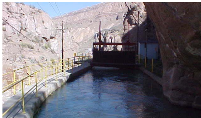
Cámara de carga
