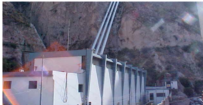
Casa de máquinas
