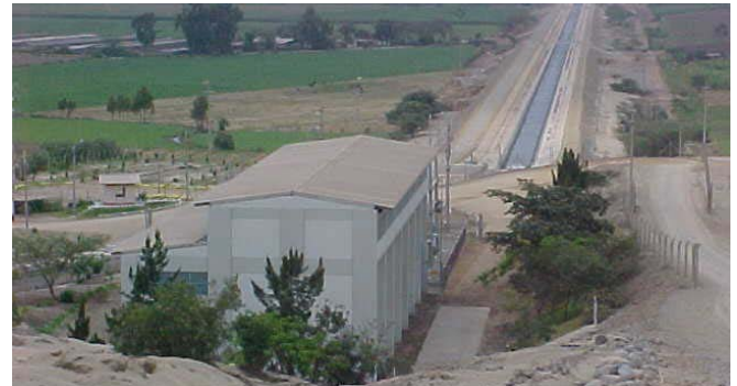
Casa de máquinas
