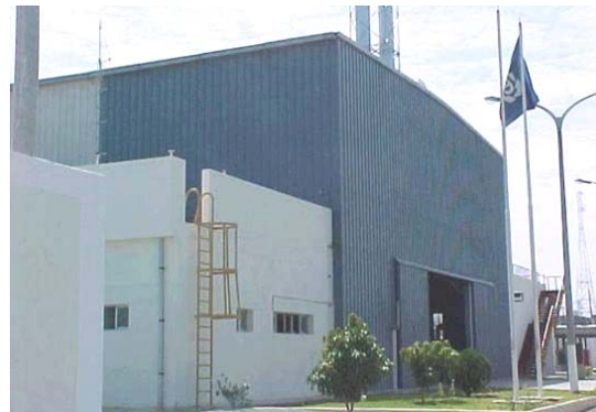
Casa de máquinas
