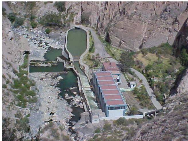
Casa de maquinas
