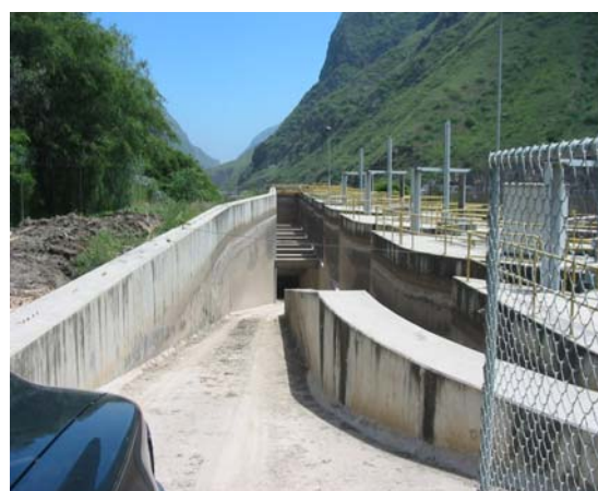
Entrada al túnel y desarenador
