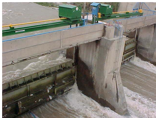
Toma de captación - río Rimac
