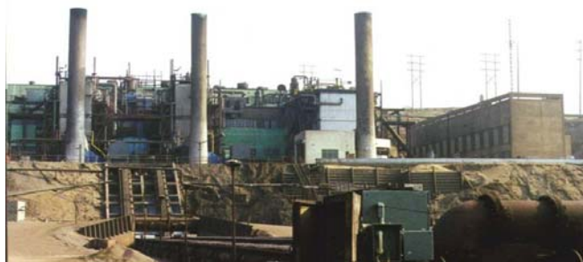
Casa de máquinas
