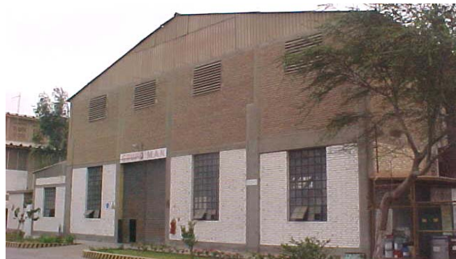
Casa de Máquinas
