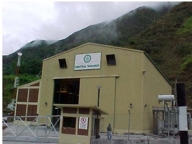
Casa de máquinas
