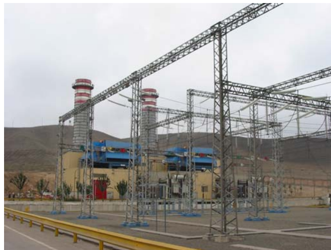
Casa de máquinas
