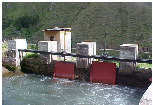
Cámara de carga
