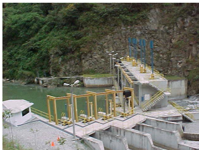
Represa y bocatoma
