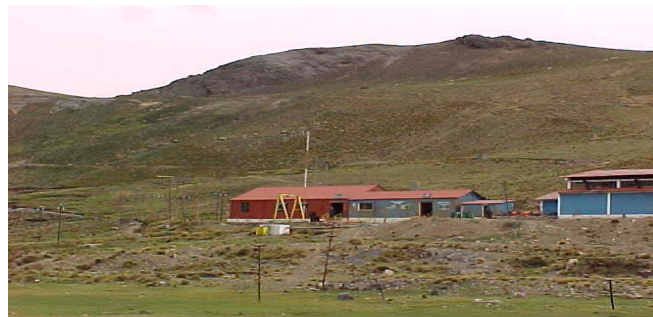
Casa de máquinas
