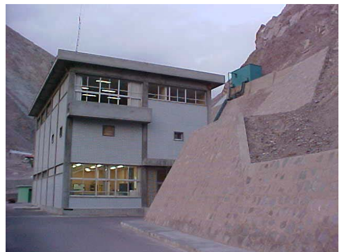
Casa de máquinas
