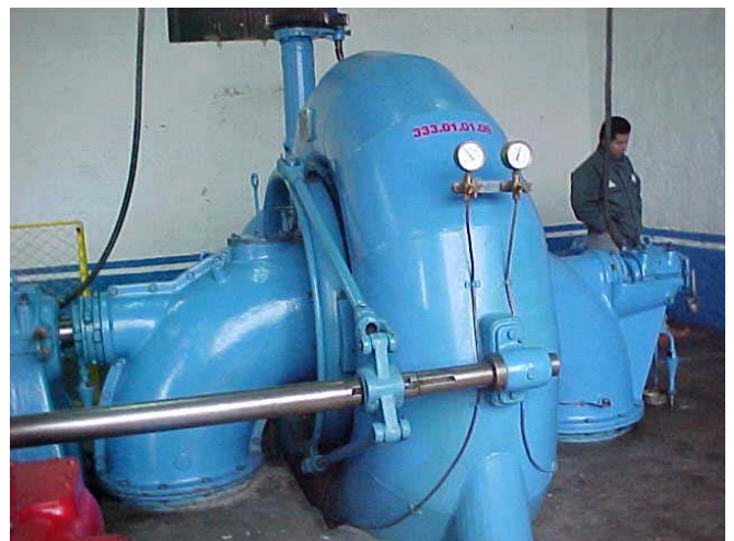
Turbina Francis – eje horizontal
