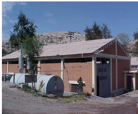
Casa de máquinas
