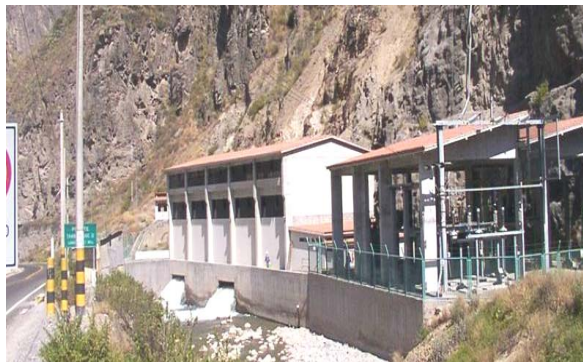
Casa de máquinas
