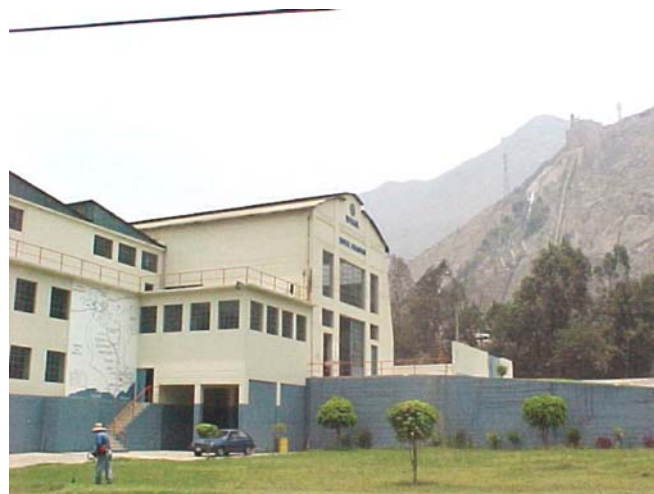
Casa de máquinas
