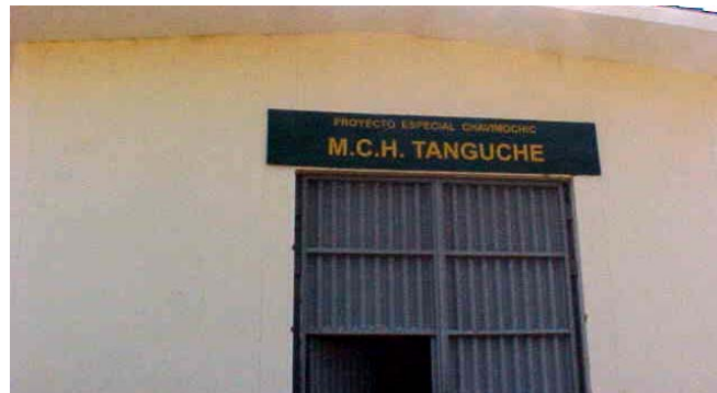
Micro Central Hidroeléctrica Tanguche
