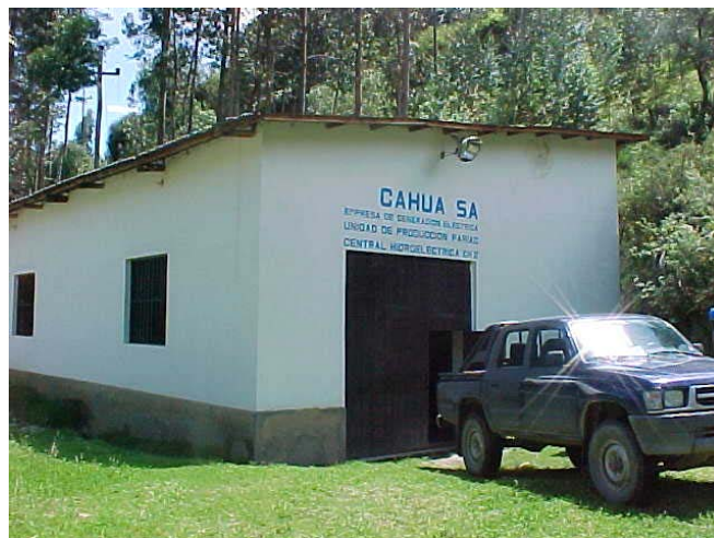
Casa de Máquinas
