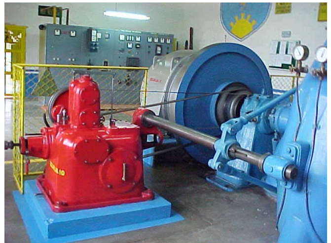
Casa de Máquinas – regulador de velocidad
