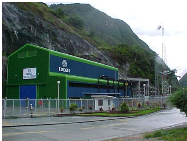
Casa de máquinas
