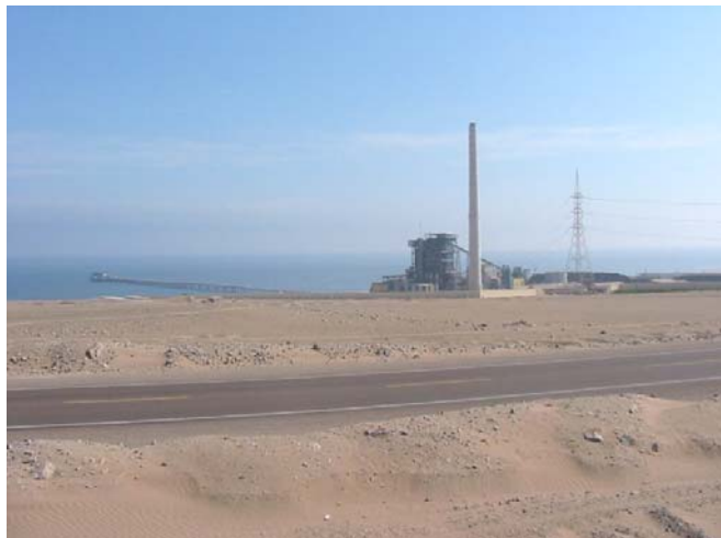
Instalaciones de la central térmica
