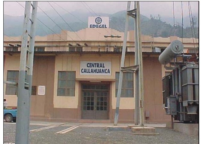
Casa de máquinas
