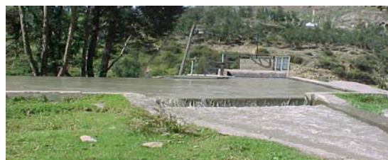
Cámara de carga
