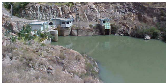
Dique de regulación Campanario
