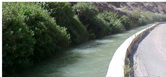
Canal de aducción
