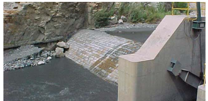
Barraje en la bocatoma
