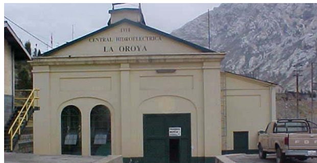
Casa de máquinas
