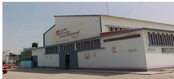
Casa de maquinas
