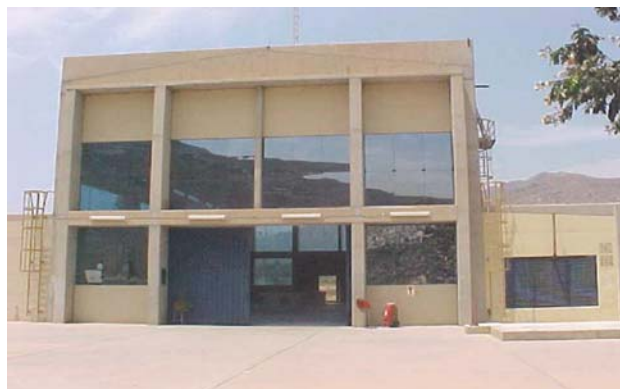
Casa de máquinas
