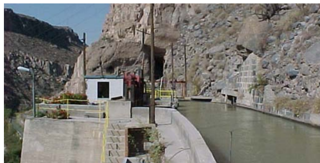
Cámara de carga
