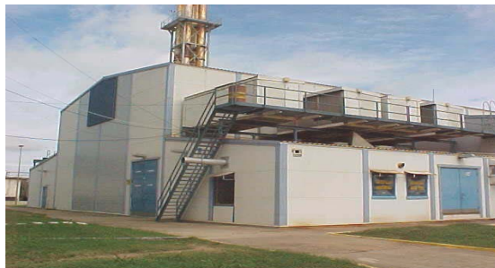
Casa de máquinas
