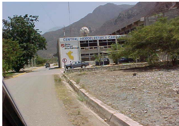
Casa de máquinas
