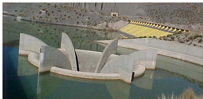
Presas Aguada Blanca
