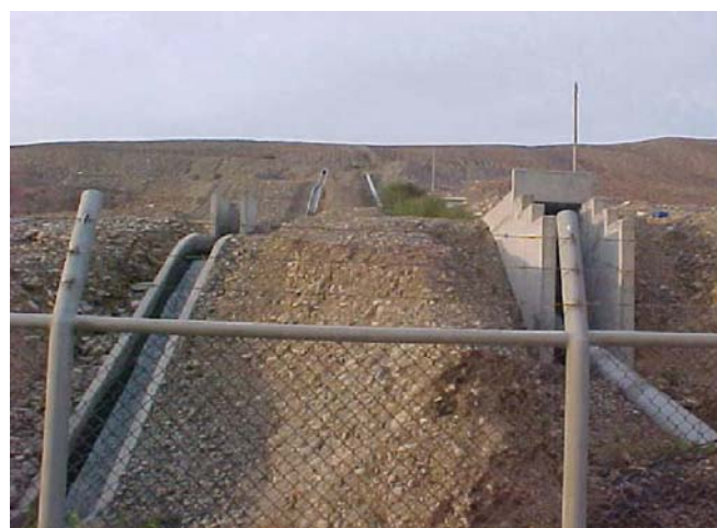
Tubería de presión
