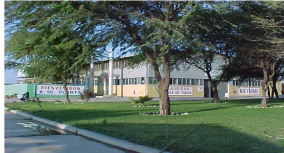
Casa de máquinas
