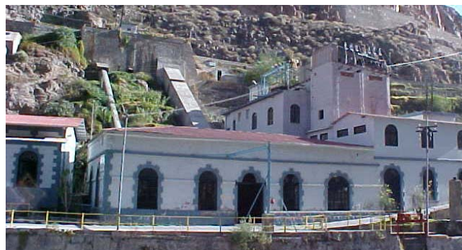
Casa de máquinas
