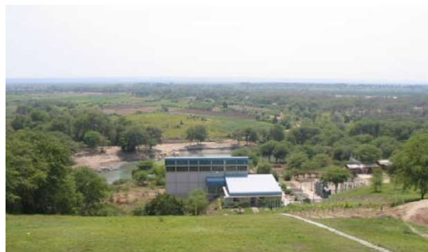
Casa de máquinas
