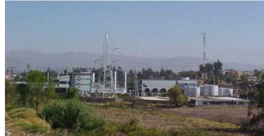
Casa de máquinas
