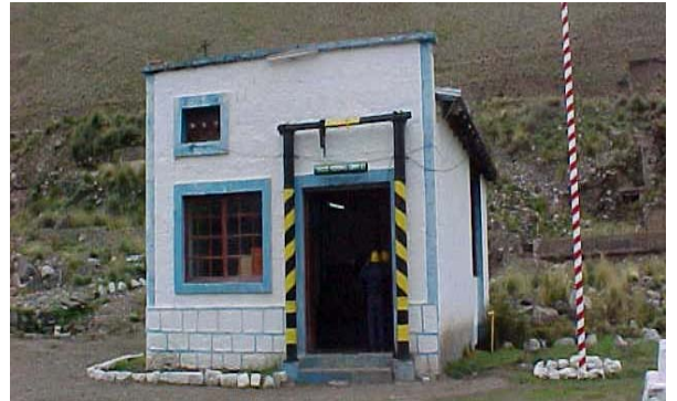
Casa de máquinas
