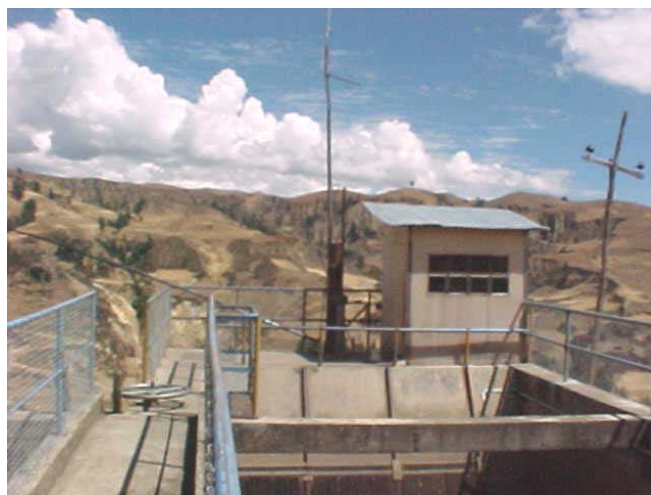
Cámara de carga
