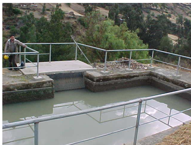
Cámara de carga
