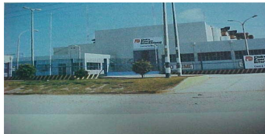
Casa de maquinas
