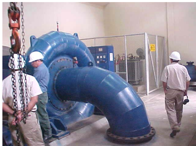
Turbina Francis eje horizontal
