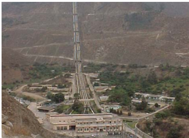
Tuberías de presión y casa de máquinas
