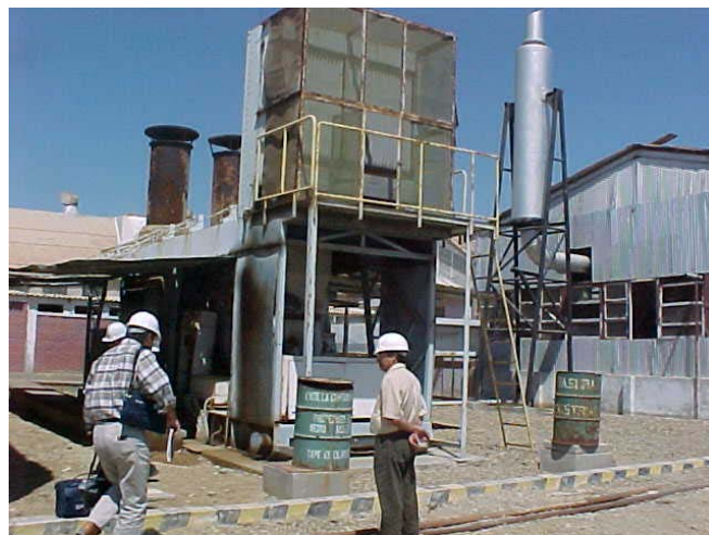
Casa de máquinas – Vista externa
