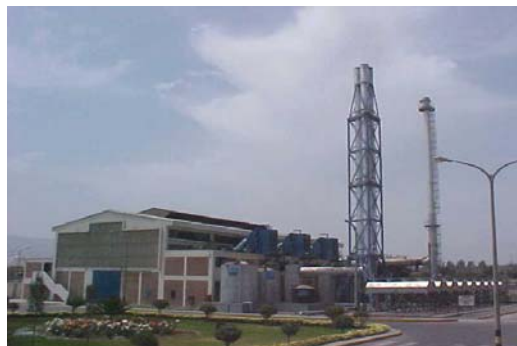
Casa de máquinas
