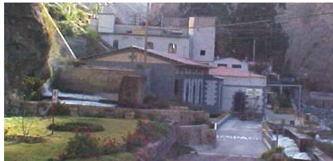
Casa de máquinas
