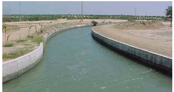
Canal de aducción
