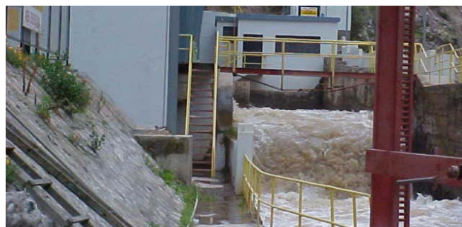
Canal de descarga agua turbinada
