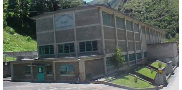
Casa de máquinas
