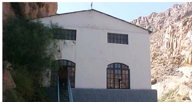
Casa de máquinas
