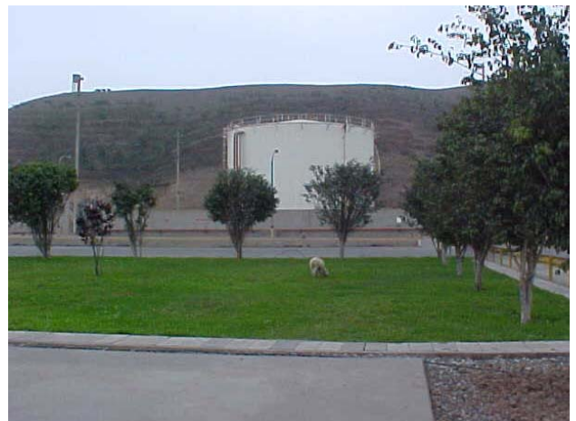
Tanque de combustible D2
