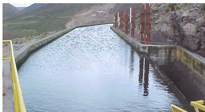
Cámara de carga
