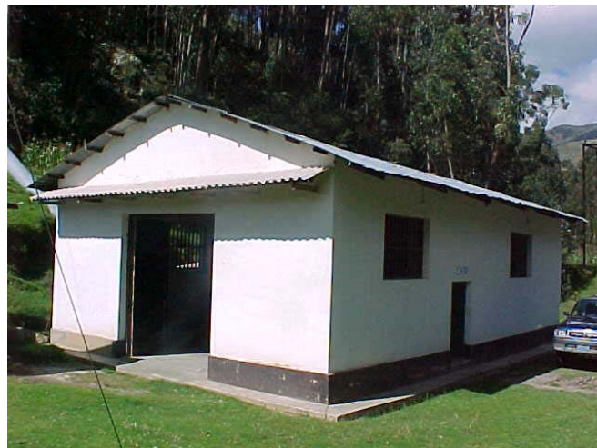
Casa de máquinas
