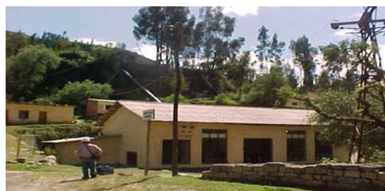
Casa de máquinas
