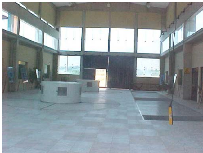
Interior de casa de máquinas
