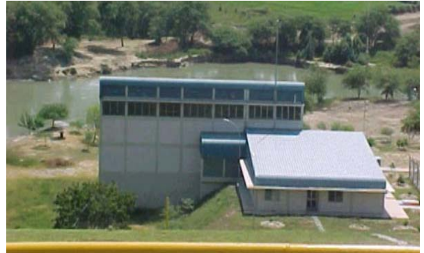
Casa de máquinas
