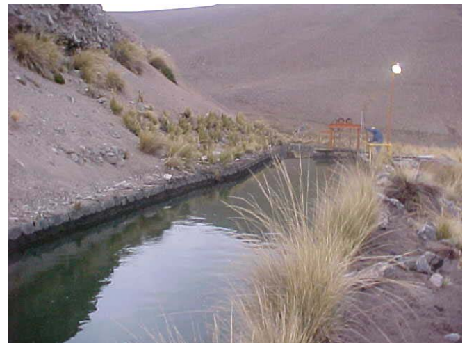
Cámara de carga
