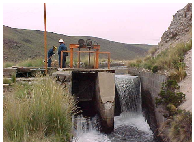
Vertedero de demasía
