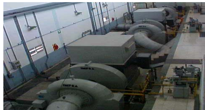
Casa de máquinas
