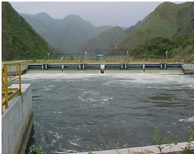
Cámara de carga
