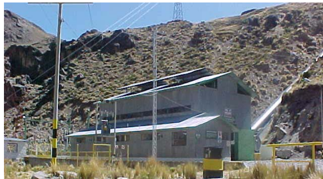
Casa de máquinas y tubería de presión
