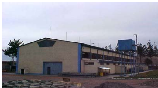
Casa de Máquinas
