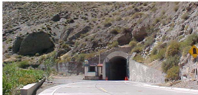
Ingreso a sala de maquinas
