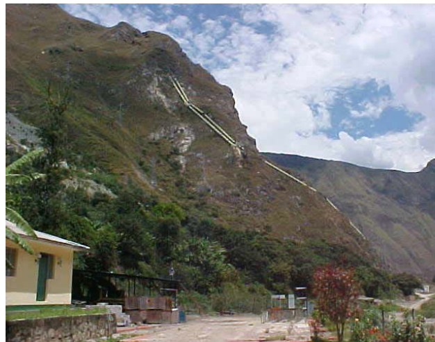
Casa de máquinas en caverna
