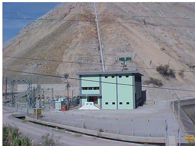
Casa de máquinas – tubería de presión
