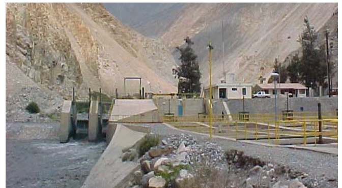
Bocatoma y desarenador
