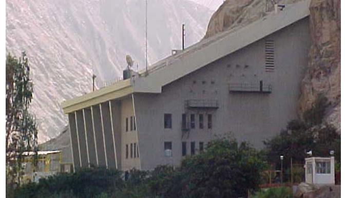
Casa de máquinas
