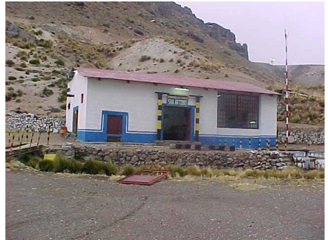
Casa de máquinas
