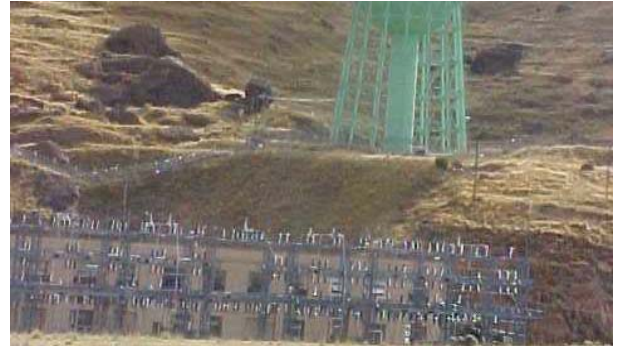
Central, con la subestación al frente y la chimenea de equilibrio
