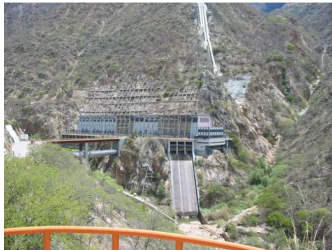
Casa de máquinas
