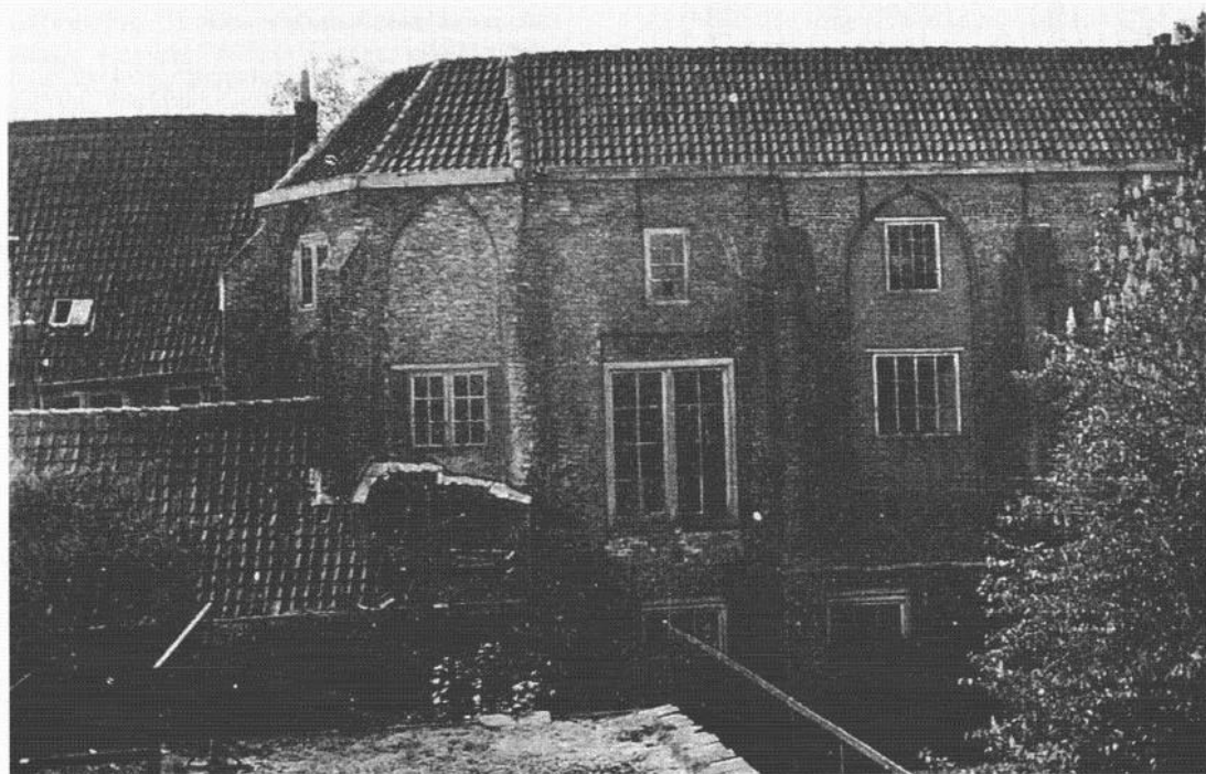
7. De eens zo belangrijke St.-Pauluskapel voor de sloop in 1943. In de muurvlakken zijn de gotische raamtraceringen nog zichtbaar.
