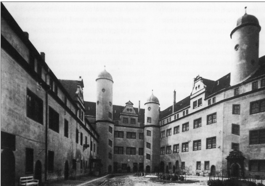
Ansicht des Innenhofs der Lichtenburg vor dem Ausbau zum KZ
