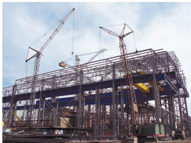
Рис. 5. Монтаж металевих конструкцій цеху безперервного розливу сталі
