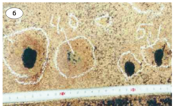
Рис. 6. Вздутия в оболочке (а) и следы от лопнувших пузырей на поверхности обечайки (б)
