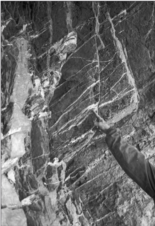
Foto 2 - Grietas híbridas en la Fm Guasasa.
