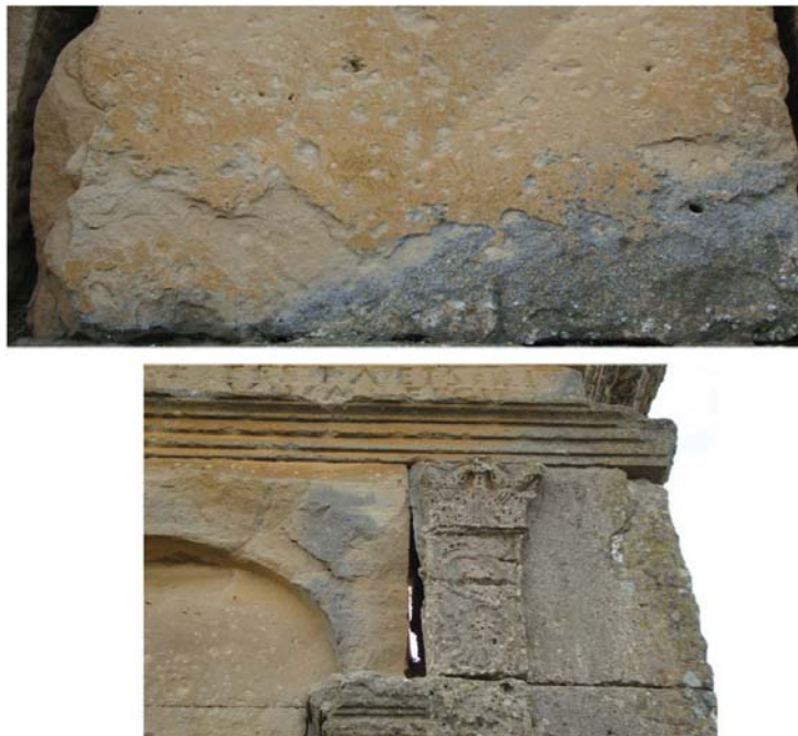
Fig. 3.- Ejemplos de deplacado en diversas zonas de la fachada norte (interior de la segunda hornacina y esquina superior derecha de la fachada).
