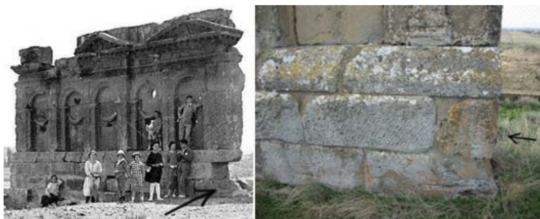
Fig.2.- Fotografía antigua del monumento en la que se señala la ausencia de uno de los sillares de la esquina y fotografía moderna con la reintegración de la misma.
