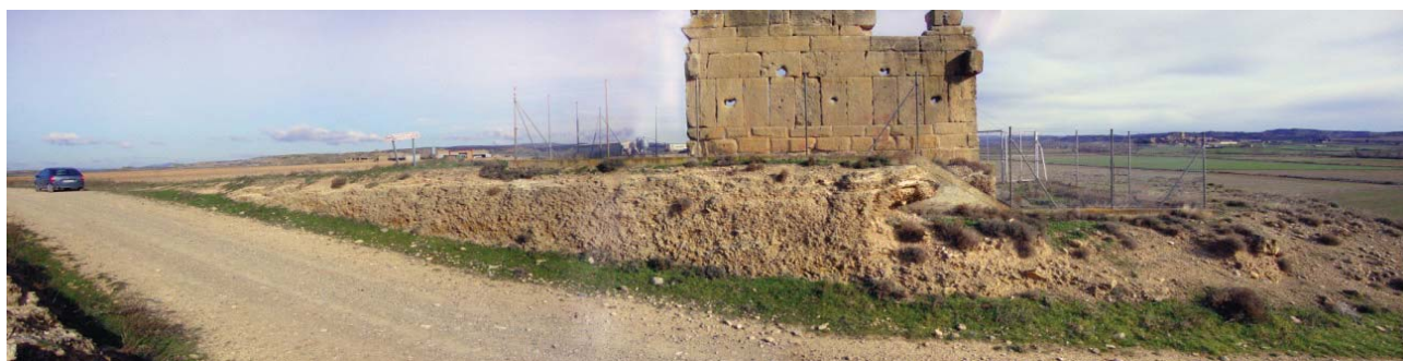
Fig. 1.- Vista de la cara sur de la fachada del Mausoleo de los Atilios. Se aprecia la terraza sobre la que se asienta así como la carretera rural que la corta.
