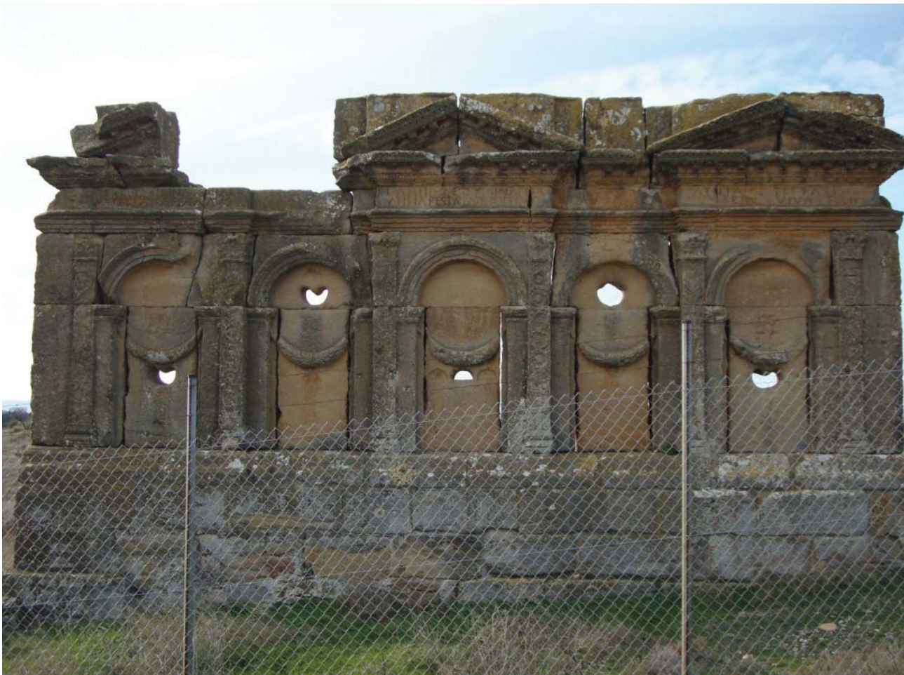
Fig.6.- Fotografía de la fachada norte del mausoleo en la que se evidencia el ensuciamiento diferencial y la humedad de la misma.
