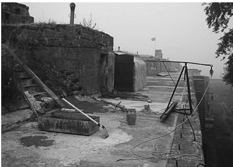
Рис. 5. Ремонт гидроизоляционной стяжки на форте «Тотлебен». Фото 2002 г.
