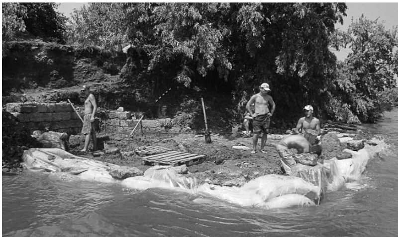
Рис. 3. Работы на участке Клиф-2
