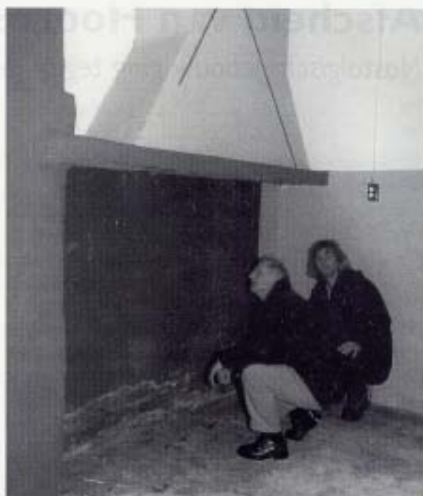
Kees Knol (rechts) inspecteert samen met Jaques Entius het rookkanaal in het voormalige binnenbadhuis dat waarschijnlijk nog een overblijfsel was van Goud- en Zilverindustrie Gebr. Roozendaal.
