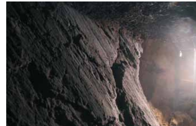
Der Tagstollen folgt einer Störungsfläche, einer ehemaligen Verwerfung, an der Erze abgeschieden wurden (Foto: Storm).
