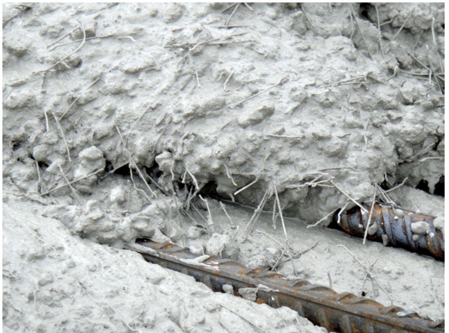
1 Kantava laatta teräskuitubetonista kaarevassa toimistotalossa Kotzebue-kadun varrella Tallinnassa.
