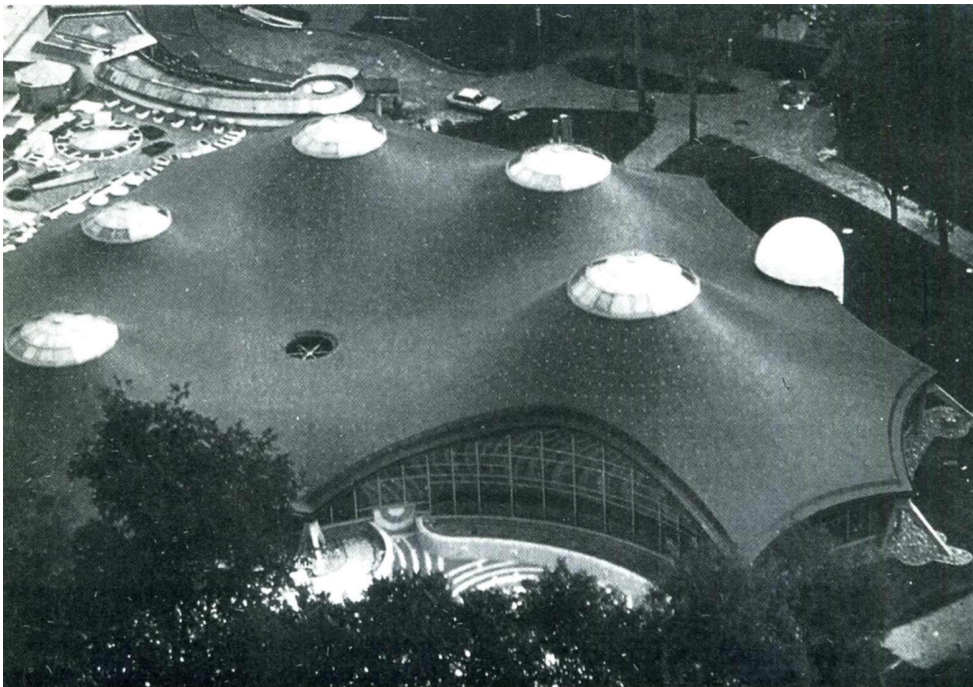
Figura 1.8. Cubierta de complejo residencial en PVC.
