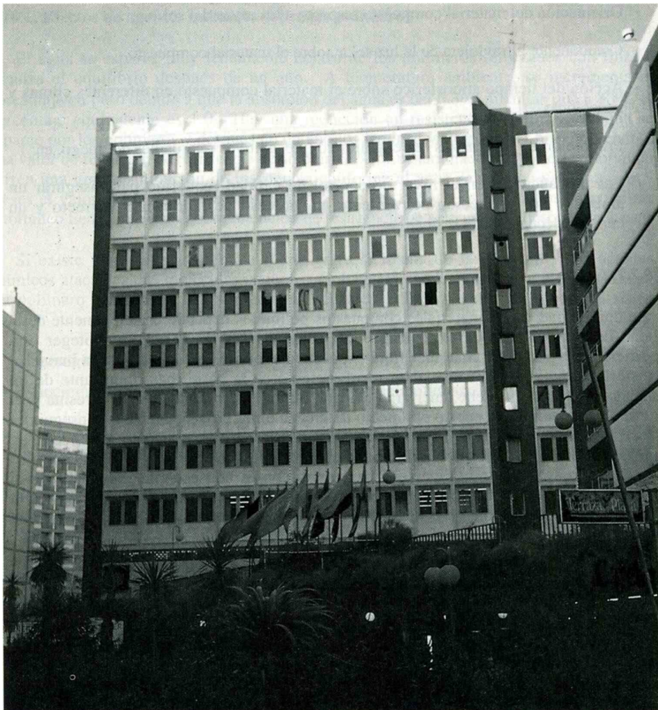
Figura 2.4. Construcción exterior realizada en materiales compuestos de fibra de vidrio y resina de poliéster donde los efectos de radiación ultravioleta del sol y el tiempo atmosférico son de gran importancia.
