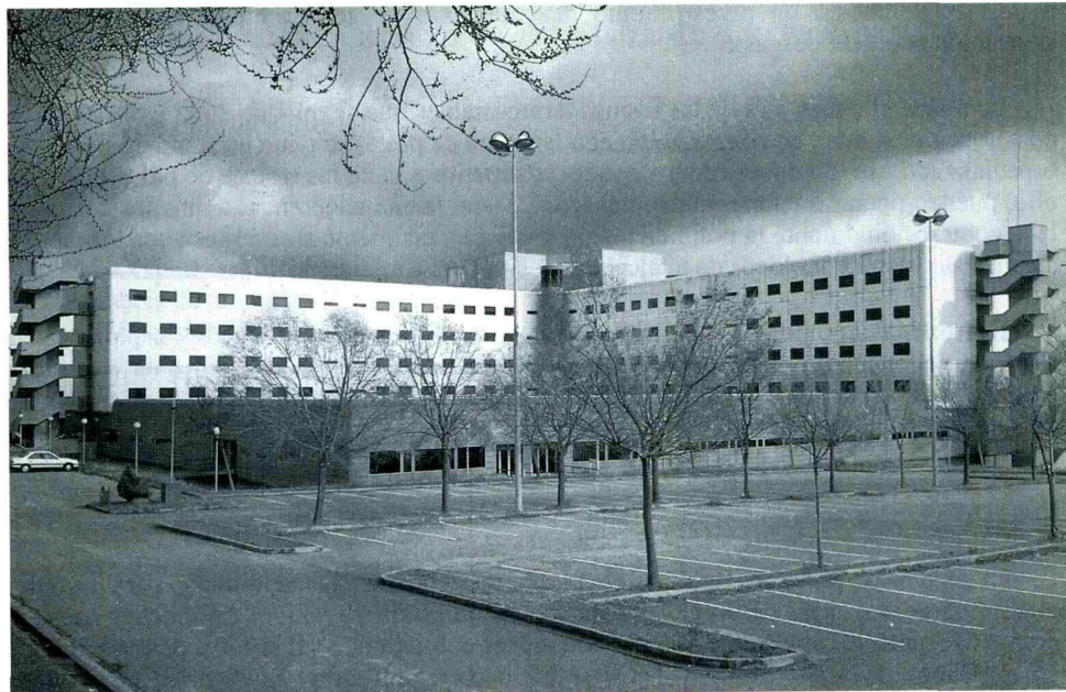
Figura 1.4. Hospital General de Cataluña. Fachada realizada íntegramente en materiales compuestos de fibra de vidrio y resina de poliéster (20.000 m 2 ).
