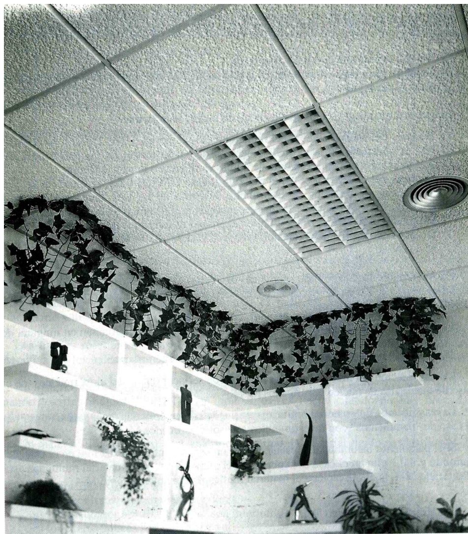
Figura 2.3. Techo de yeso reforzado con fibra de vidrio cuya clasificación ante el fuego es M-0.
