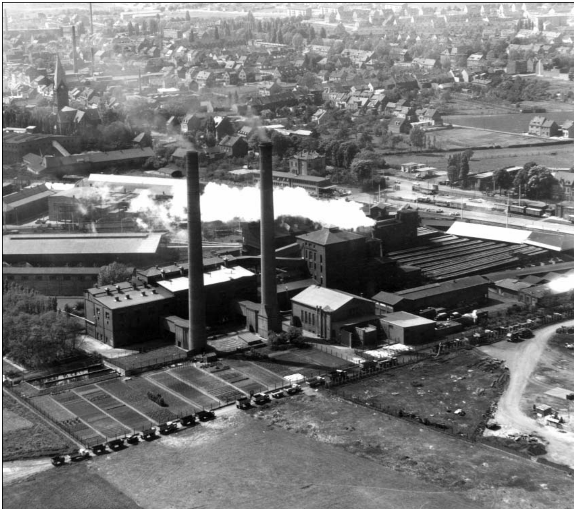
Luftaufnahme von der Ostseite der Brikettfabrik Clarenberg. Deutlich zu erkennen ist die lange Lkw-Kolonne der Brikethändler auf dem Weg von Neuhemmerich nach Frechen zur Landabsatz-Verladung.
