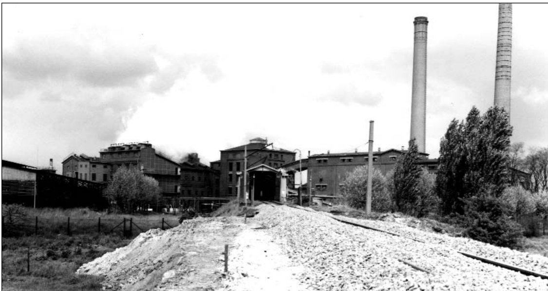
Die Gleisschwellen der Zufahrt zum Rohkohlenbunker (1.600 t Fassungsvermögen) der Brikettfabrik Clarenberg wurden 1962 mit frischem Schotter gestopft. (Foto: RWE Power AG)
