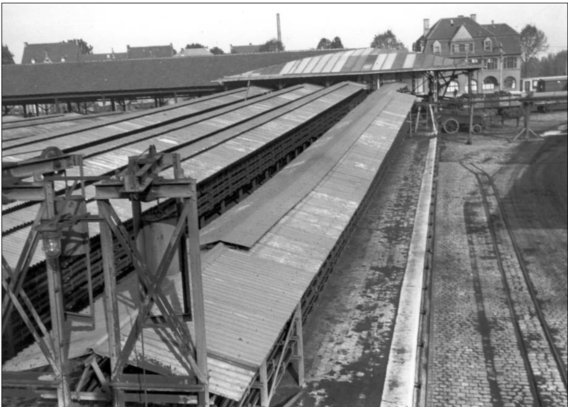
Oben: Blick auf das Pressenhaus der Brikettfabrik Clarenberg. Das Foto wurde um 1910 von der Firma Buckau für eine Werbebroschüre benutzt; unten: das breite Brikettrinnenfeld und der Verladeschuppen, dahinter der Bahnhof Frechen.
