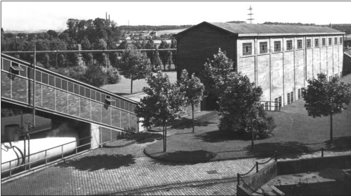
Rohkohle-Großraumbunker der Brikettfabrik Clarenberg
