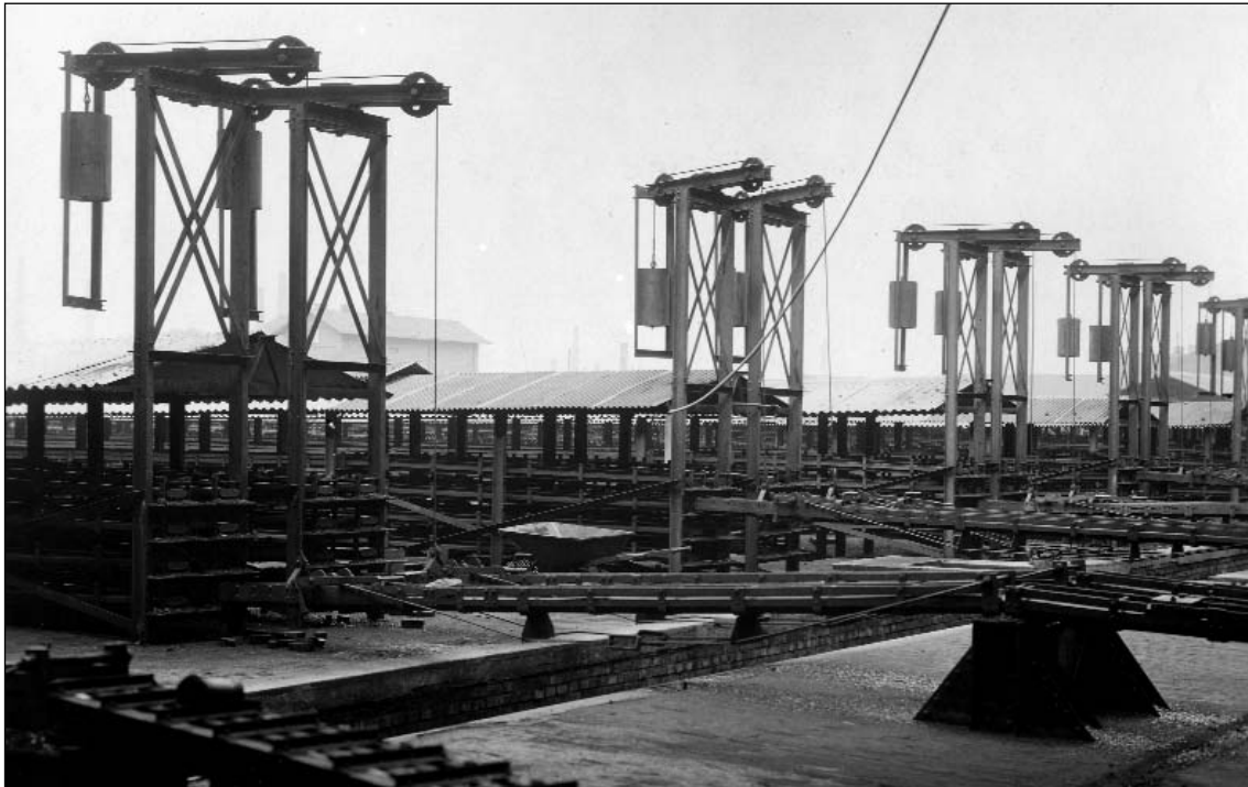
Im Vordergrund die mächtigen Schwenkrinneneinrichtungen und die Ausbrechvorrichtungen für die Brikettstränge. Im Hintergrund die überdachten Kühlrinnenbatterien für die frischen Briketts. (Foto: RWE Power)
