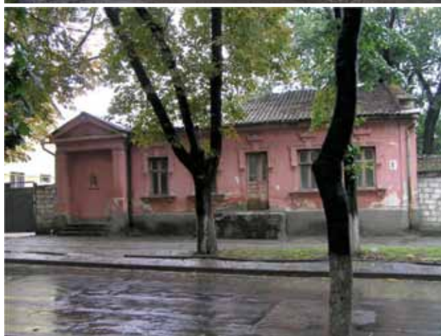
Tipologie de imobil specific centrului istoric al Chișinăului
