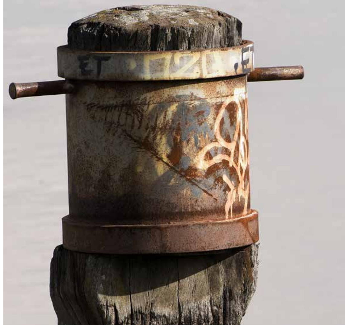
◀ Un ancien canon d'amarrage constitué d'un pieu de chêne surmonté d'un cercle de fer, quai de Paludate, Bordeaux.
