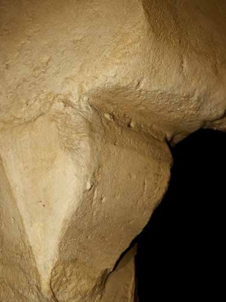
◀ Détail d'une des frises supportant la hotte de la cheminée.
