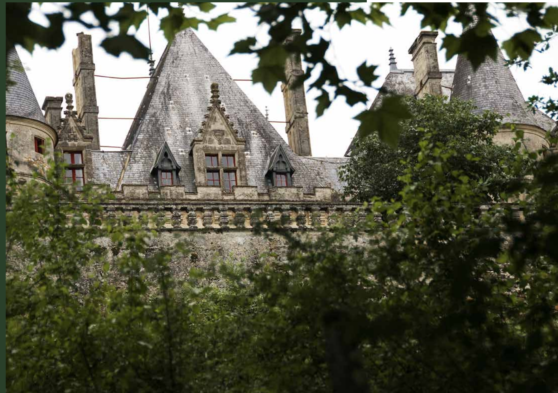
▲ Façade nord-ouest du château de Montaigne avec sa belle terrasse du xvi e siècle.
