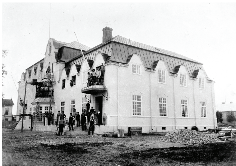
Scharinska villan sedd från sydost under uppförandet 1905 VBM
