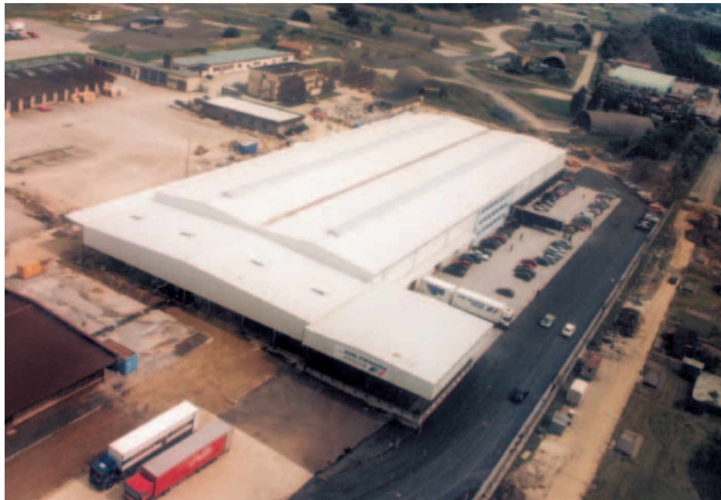
1997 – zentrales Frachtterminal auf dem Flughafen Hahn 6180 qm Lagerhalle, 1800 qm Rampenfläche, Umschlagskapazität 60 000 Tonnen pro Jahr.
