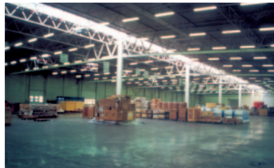
Innenansicht des zweiten Air-France-Frachtterminals am Flughafen Frankfurt-Hahn.
