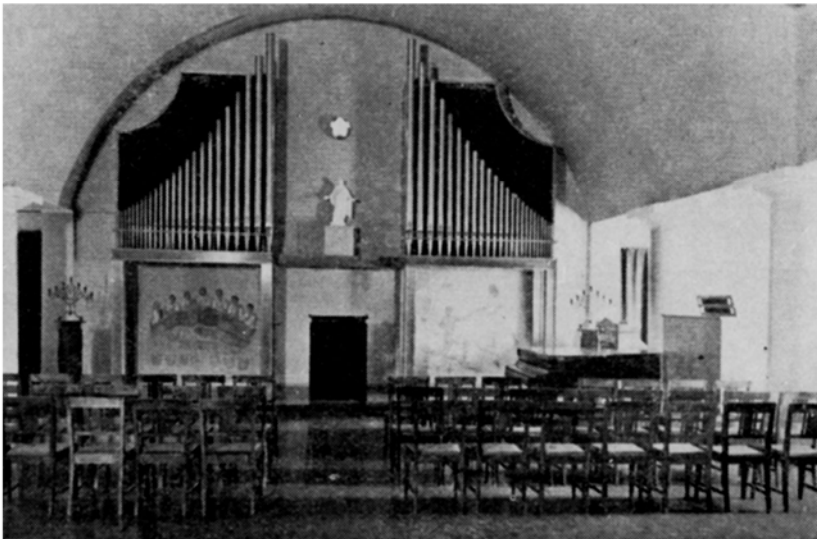
Kulmakoulun juhlasali tulipalon jälkeen uusittuna.
