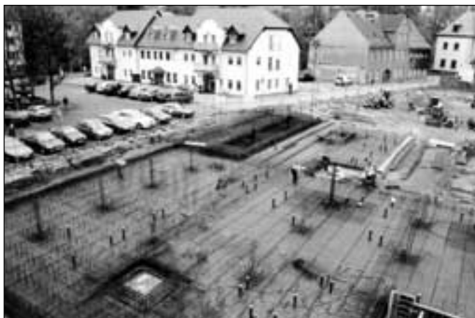
Baugeschehen im Oktober 2008; Foto: H. Schmidt
