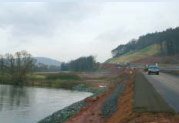
Abb. 35: Böschungssicherung an der Lahn bei Wolfshausen durch das ASV im Rahmen des B3-Ausbaus
