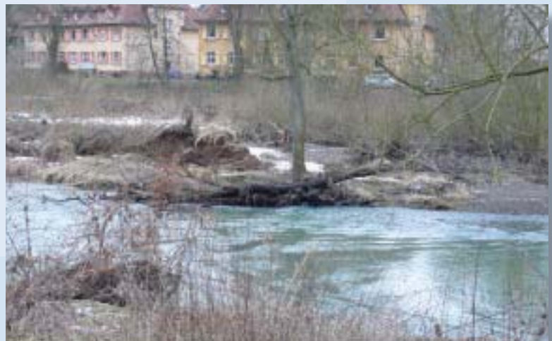
Abb. 49: Aufweitung und Verzweigung der Lahn im urbanen Bereich. Das Foto zeigt einen künstlich hergestellten Nebenarm der Lahn in Marburg-Weidenhausen. Foto: Werner Gleim
