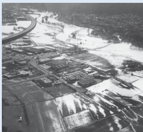
Abb. 9: Hochwasser der Lahn am 8.2.1984 bei Wehrda und Argenstein. Foto: Kieselbach
