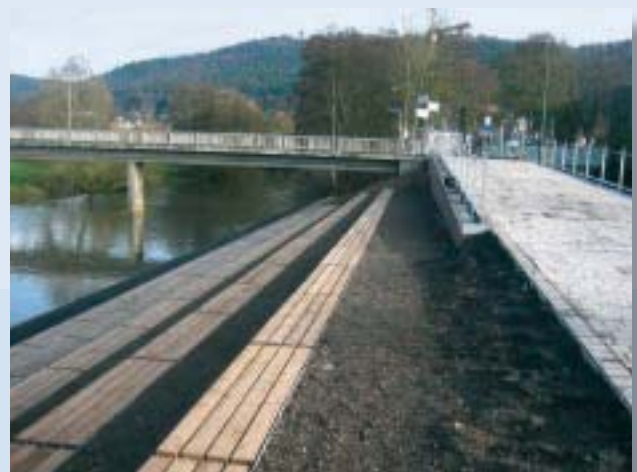
Abb. 36: Böschungssicherung und Uferneugestaltung der Lahn in Marburg, nahe Mensa
