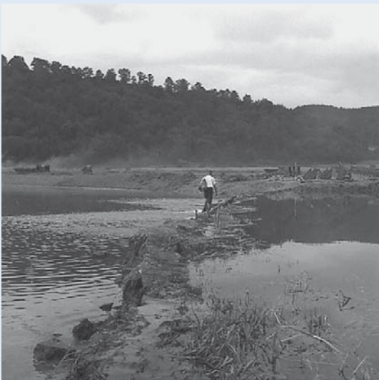
Abb. 30: Ausbau der Lahn zwischen Cölbe und Marburg 1938 mit Sprengung des Lahndurchstiches der Lahnschleife bei Cölbe.
