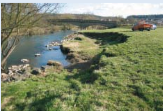
Abb. 33: Uferabbruch an der Lahn bei Sichertshausen
