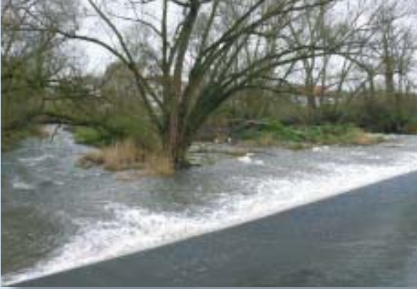
Abb. 39: Erhaltung alter Gehölzstrukturen und Gewässerverzweigungen unterhalb des Lahnwehres in Roth. Die Entwicklung der Gehölze wird beobachtet, um rechtzeitig einer Verklausung des Gewässerbettes und damit der Hochwassergefährdung der Ortslage vorbeugen zu können.
