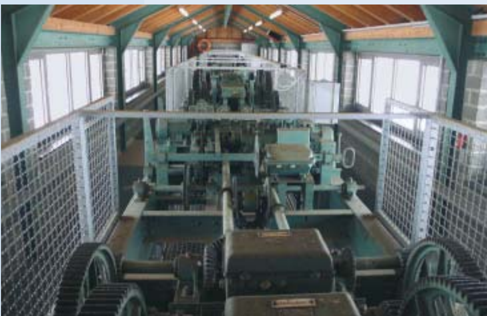
Abb. 20 ◀▶: Blick auf den Antrieb der Absperrschütze. Die Antriebsteile sind noch die beim Bau des Absperrbauwerkes verwandten Maschinenteile.
