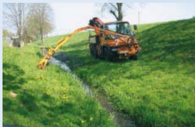
Abb. 32: Reinigungsarbeiten am Dammseitengraben
