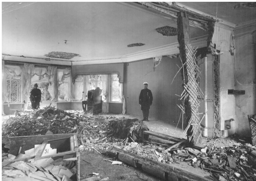
Последствия взрыва дачи П. А. Столытина на Аптекарском острове. Фото 1906 г.
