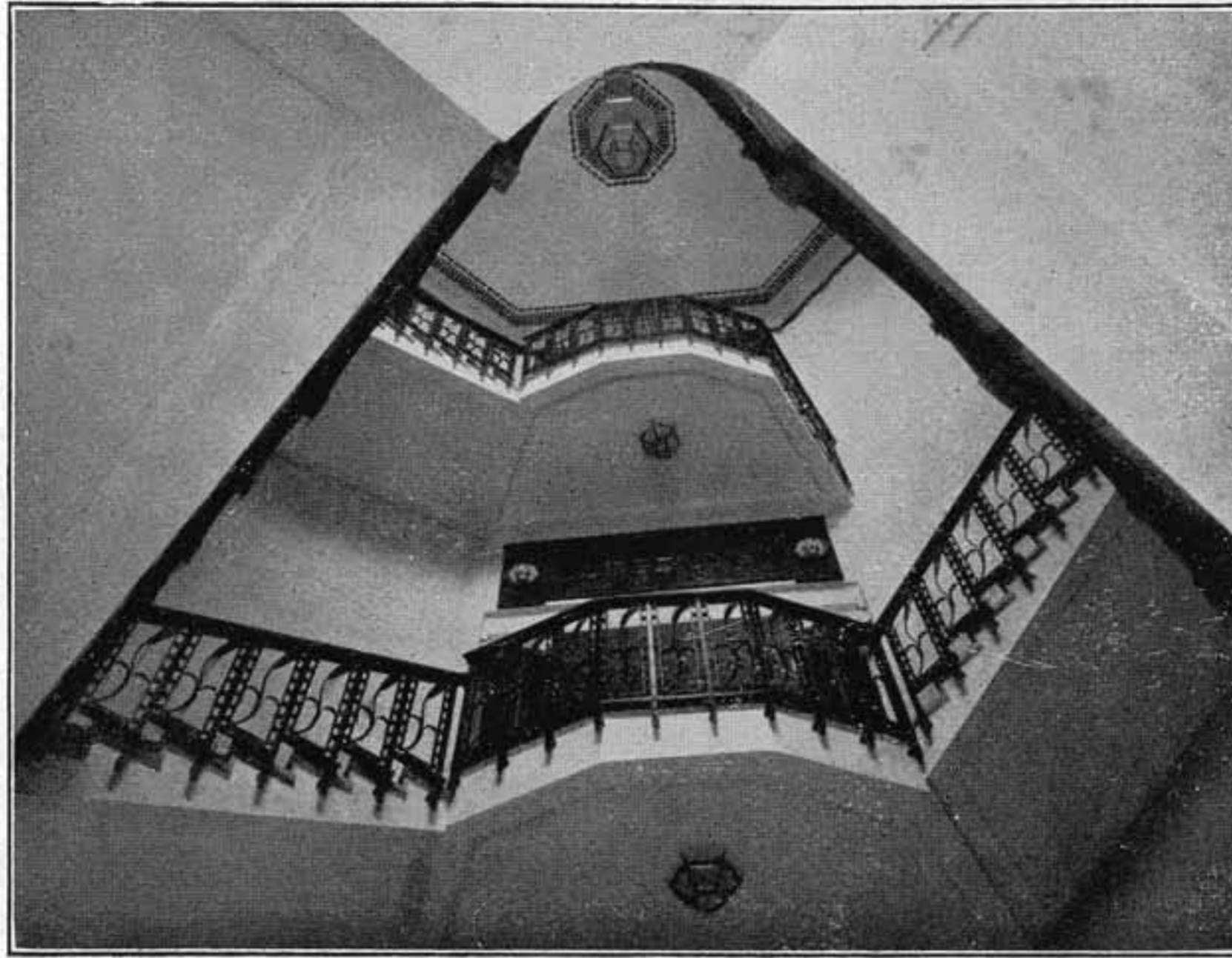
Fig. 9. - ARCH. FRANCESCO FICHERA: PALAZZO DELLE POSTE IN SIRACUSA. SCALA PRINCIPALE.
