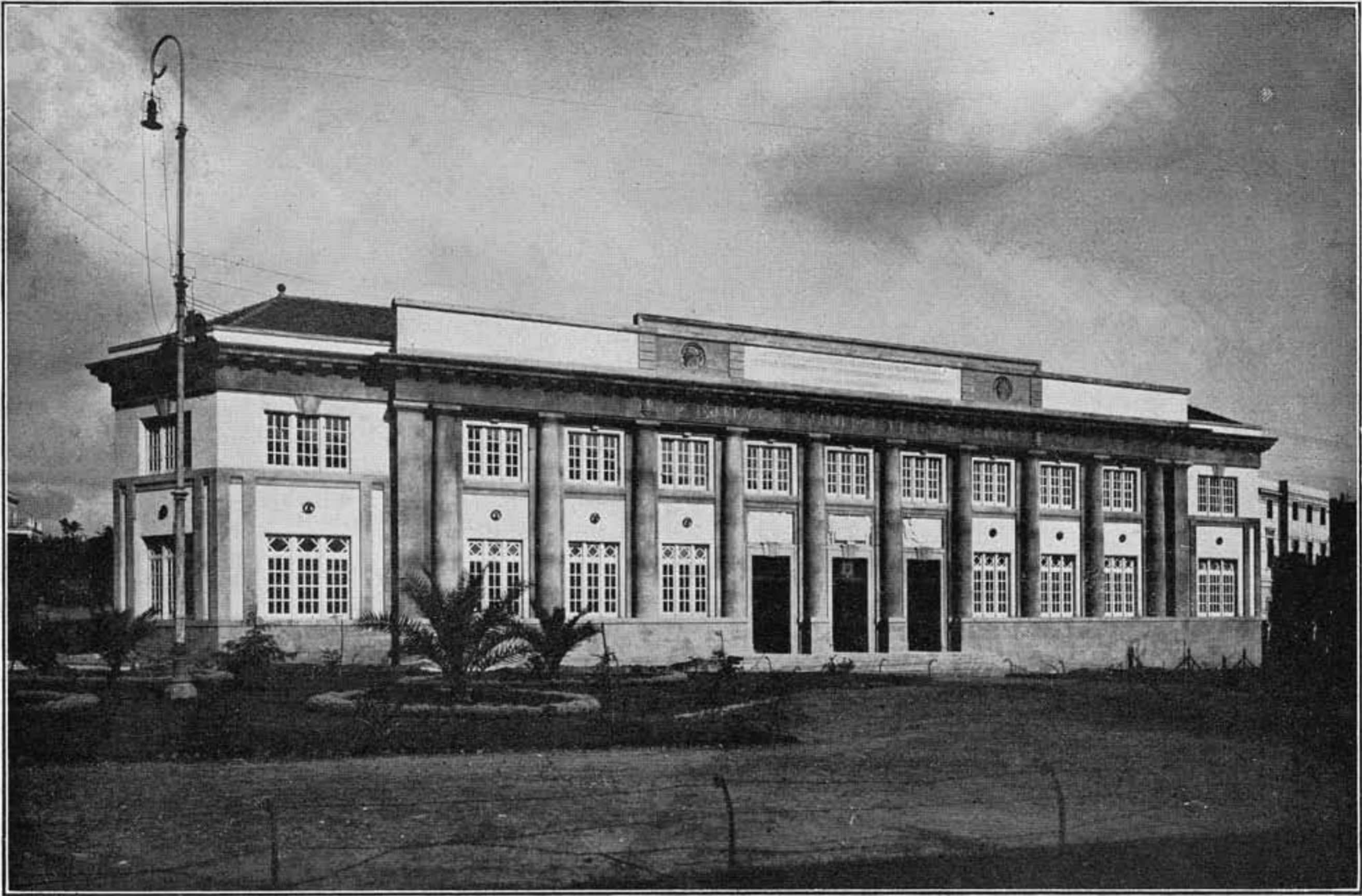
Fig. 21. - ARCH. FRANCESCO FICHERA: R. ISTITUTO COMMERCIALE IN CATANIA - FRONTE.
