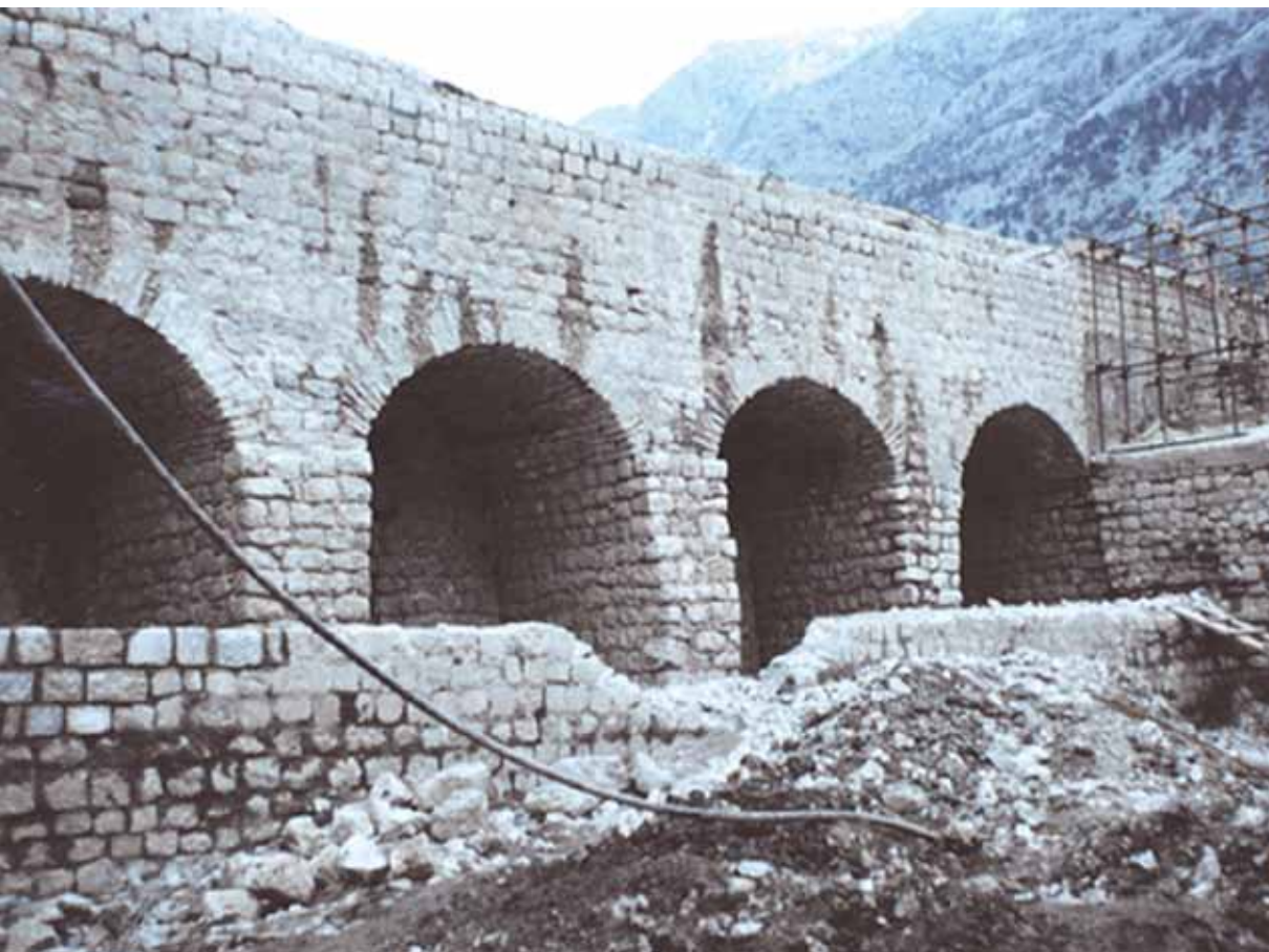
Сл. 2. Сјеверна корџина-басџиона шраса, унутрашњи изглед, у току радова
