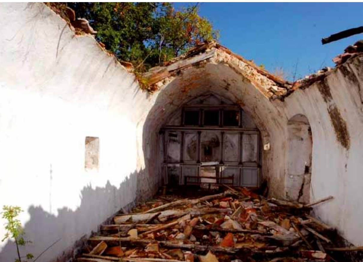
Унутрашњост цркве са срушеним сводом млађе фазе (прије припремних радова)
