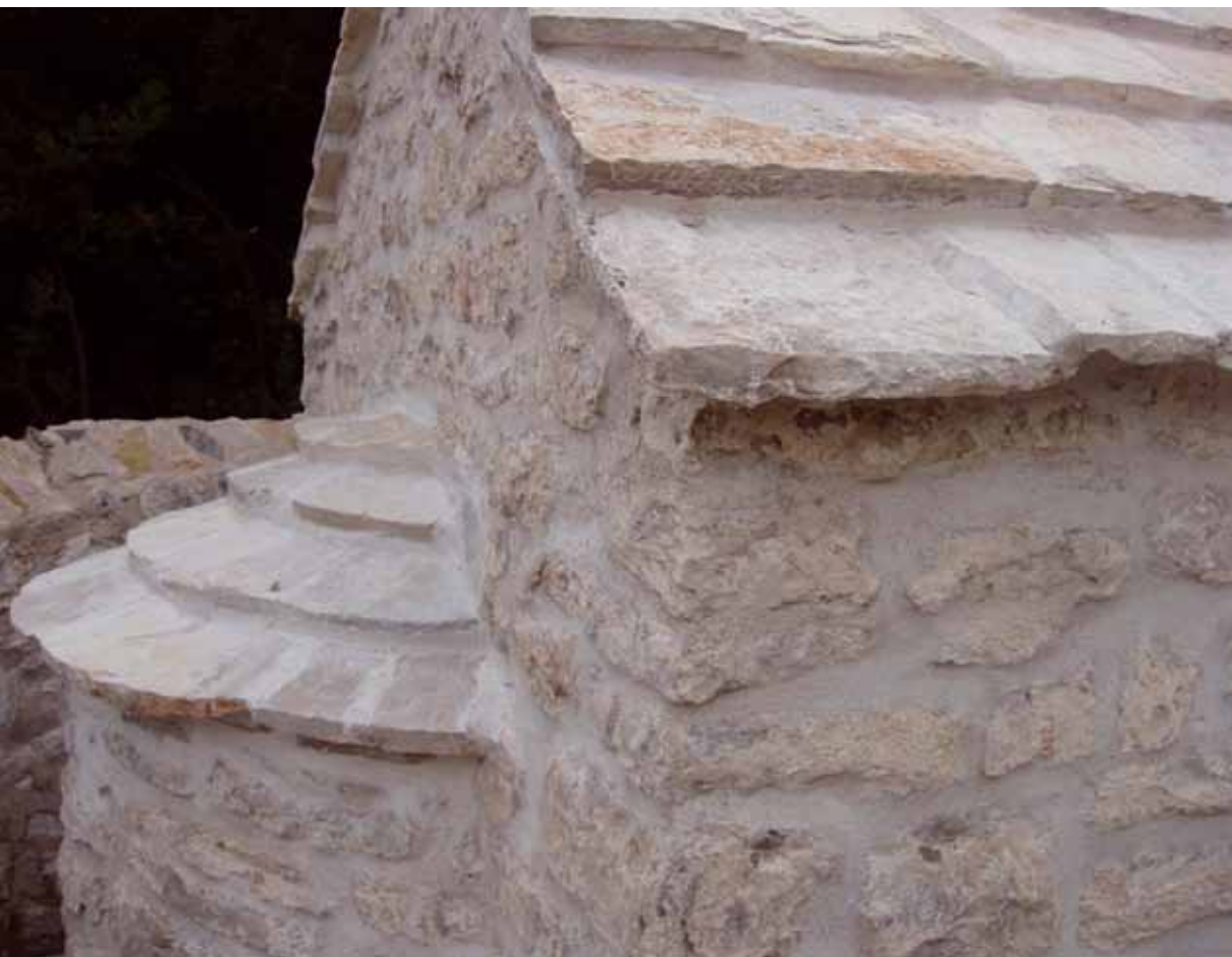
Sl. 15 Krovni pokrivač od kamenih ploča
