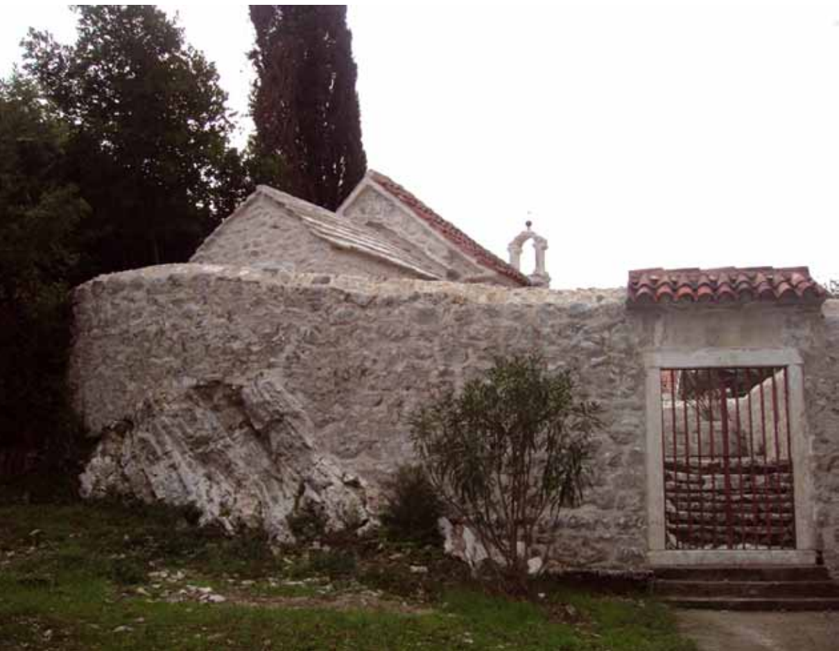
Sl. 14 Pogled na ansambl sa istoka, posle radova
