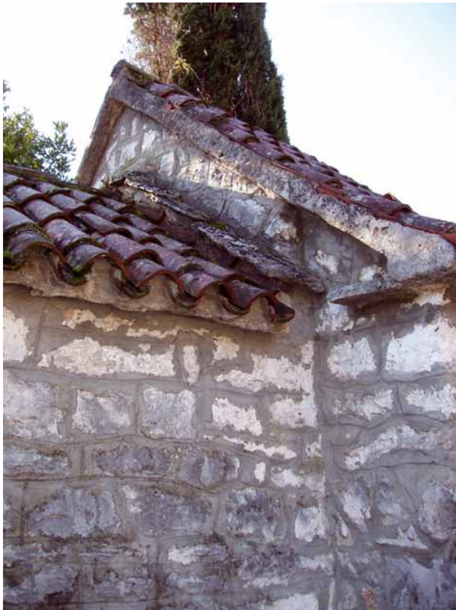
Sl. 10 Spoj starijeg i mlađeg dijela građevine
