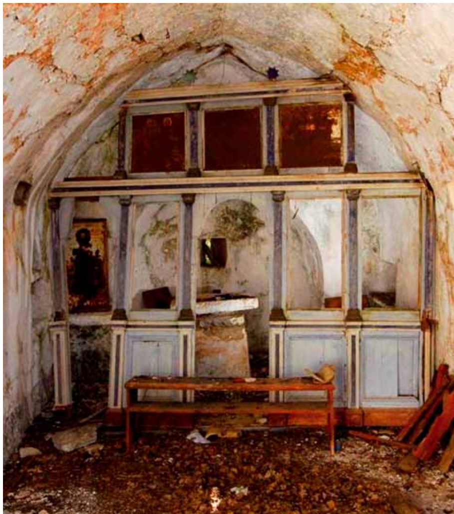
Изглед олийарског њростора (њрије њрињремних радова)
