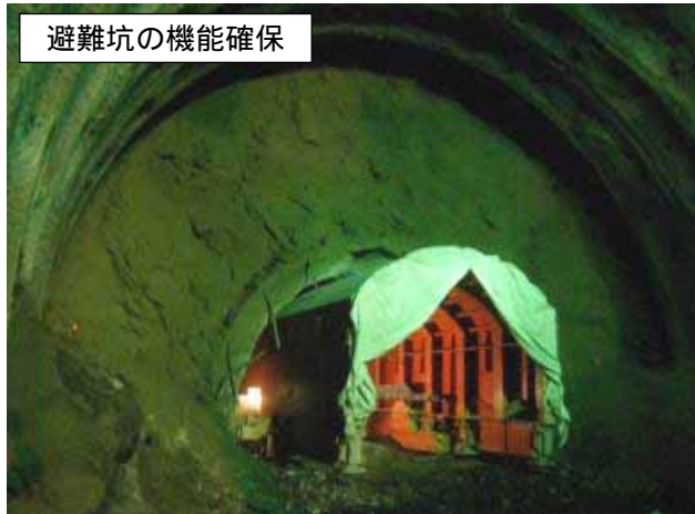
本線部避難坑防護プロテクター
