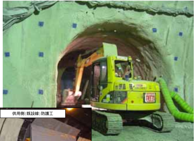
避難連絡坑拡幅状況
