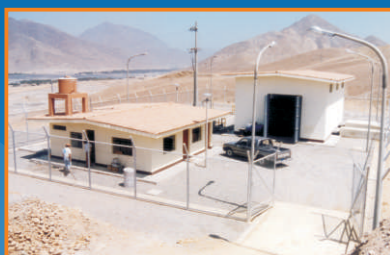
Casa de Máquinas
