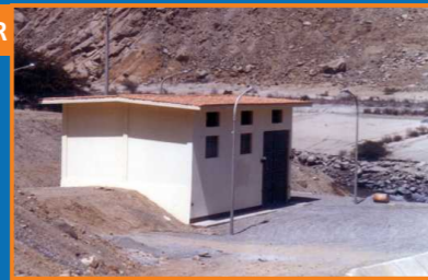
Casa de Máquinas
