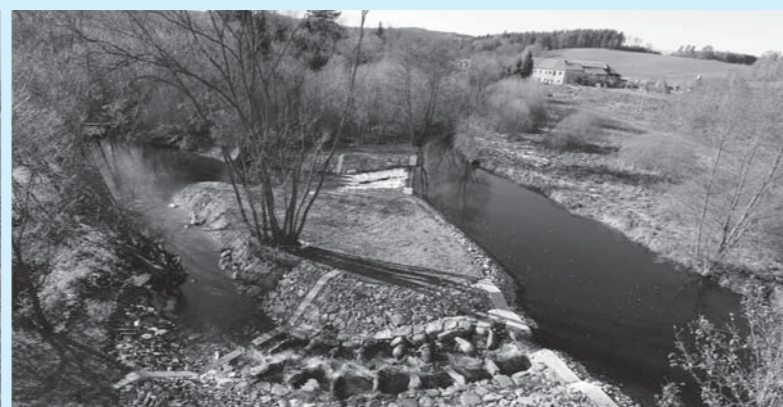
Malše ř.km 62,373 – rekonstrukce jezu Jílek
