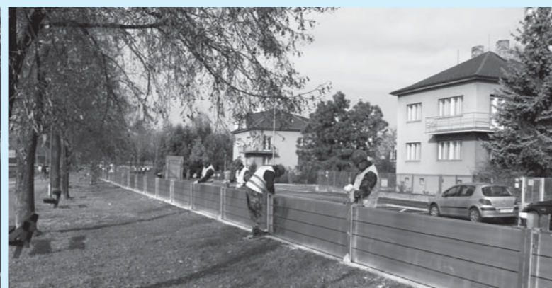
České Budějovice, protipovodňová ochrana Jiráskovo nábřeží ulice Budivojova – Nový most
