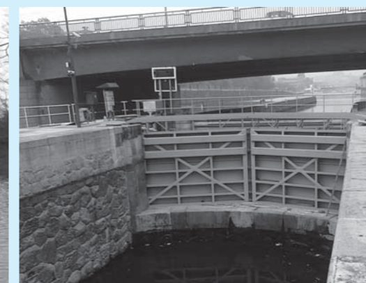
Vltava ř.km 50,690, vodní dílo Štvanice – oprava horních vrat velké plavební komory
