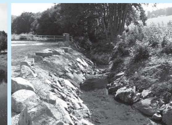
Bystrý potok ř.km 2,660–2,850, Kocourov – oprava koryta
