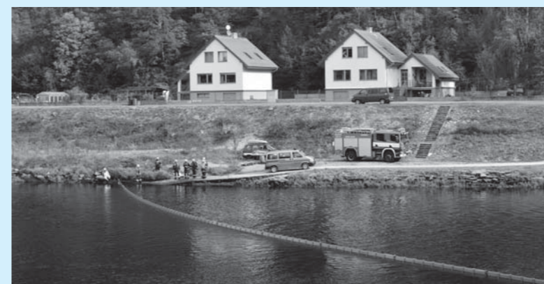
Instalace norné stěny
