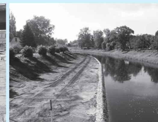
Nežárka ř.km 0,000–1,016, Veselí nad Lužnicí – oprava opevnění kynety
