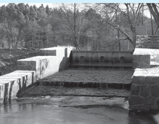
Nežárka ř.km 26,732, jez Šimanov – oprava vorové propusti
