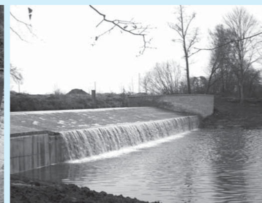
Radbuza ř.km 47,798 jez Holýšov – oprava tělesa jezu
