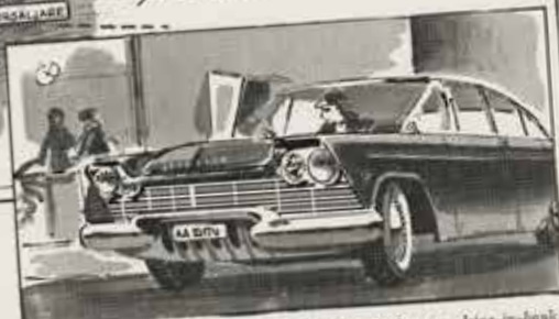
Vid utarten på Katarinavägen har Enskilda Banken en drive-in-bank. Bilisterna behöver inte stiga ur. Rutan till banklokalen har skottstreck glas.
