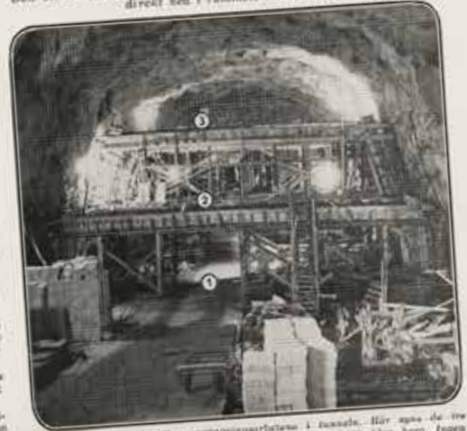
1932 började de egentliga sprängningsarbetena i tunneln. Här syns de tre våningarna i bergarummet. Man har sprängt bort 105 000 kubik berg. Ingen olycka har inträffat under det jätteåta arbetet.
