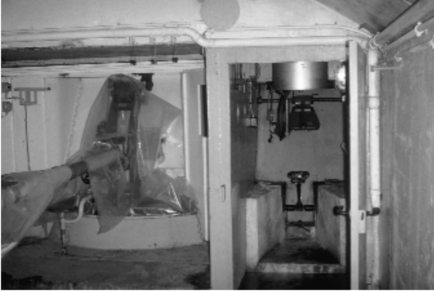
En haut: vue intérieure sur la casemate armée d'un canon antichars de 9 cm A droite: la position de l'observateur
