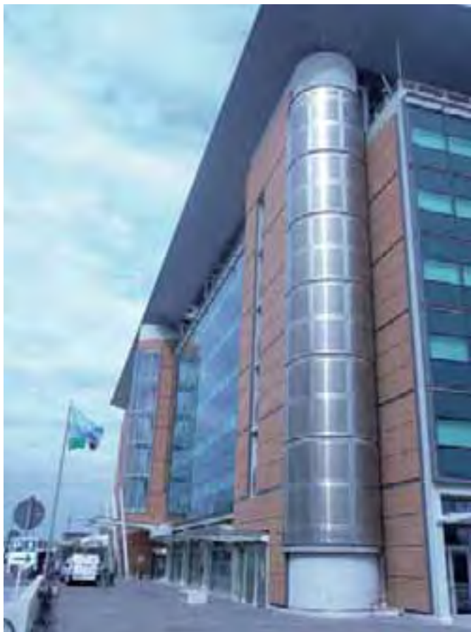
Figura 3 - "Laguna Palace" a Mestre. Il laterizio è qui usato come rivestimento a secco per la parete ventilata e per stemperare, col suo caldo colore, le freddezza dell'acciaio e del vetro
