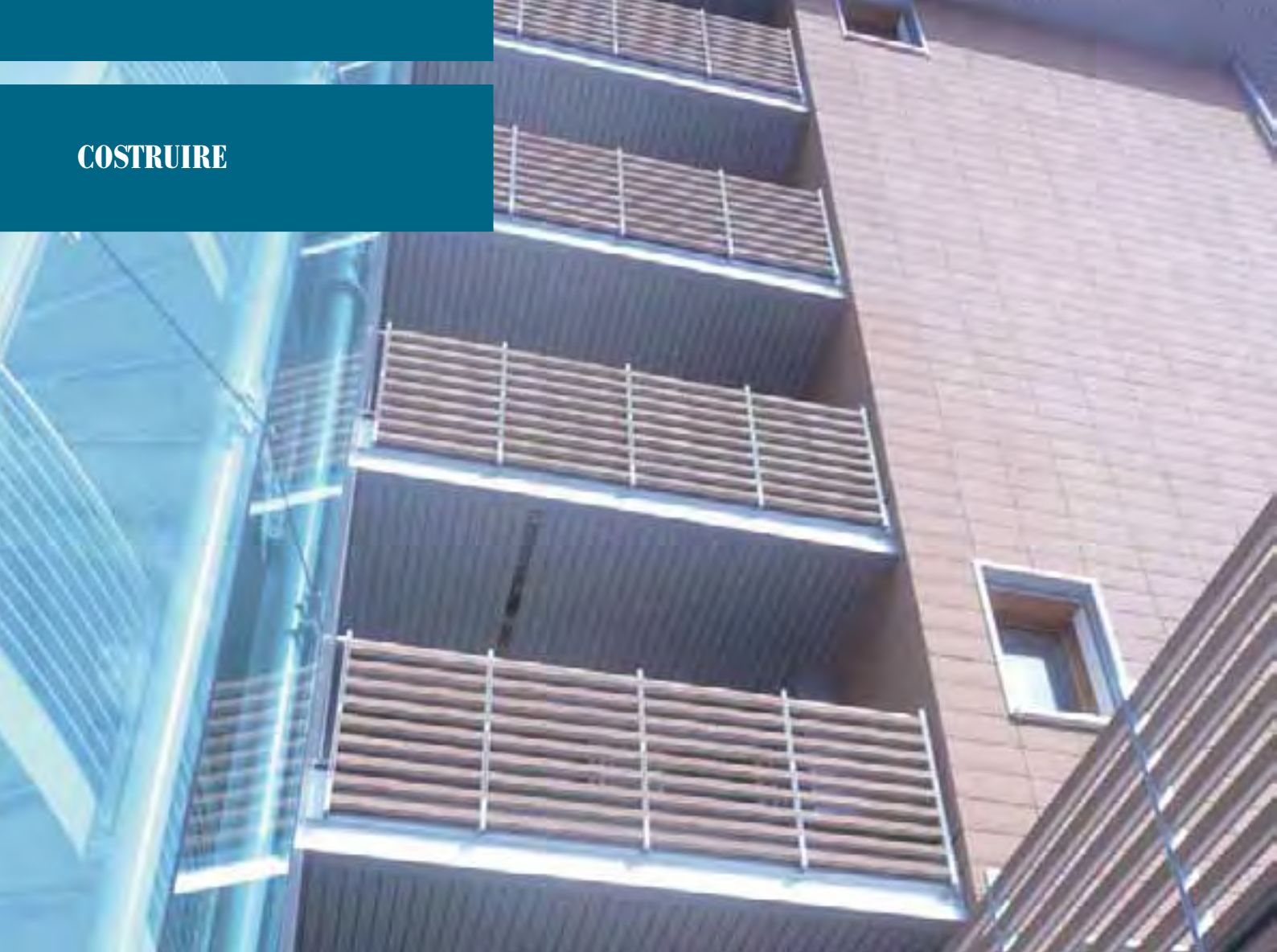
Figura 1 - Palazzina di nuova costruzione a Mestre, decisamente significativa per l'utilizzo del laterizio a secco in vari frangenti
