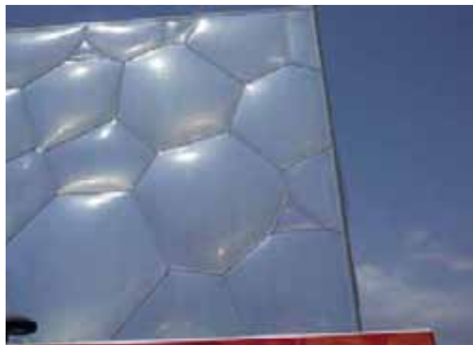
Centro Acquatico Nazionale di Pechino - Water Cube (dettaglio)
