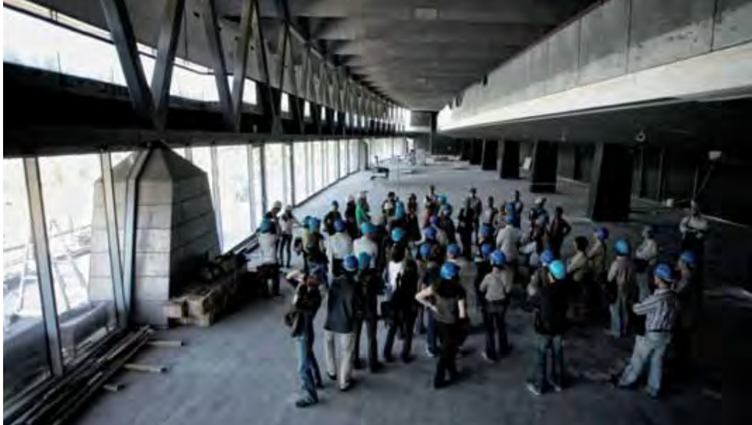
Torino. Visite guidate alla città in costruzione: cantiere del Museo dell'automobile
