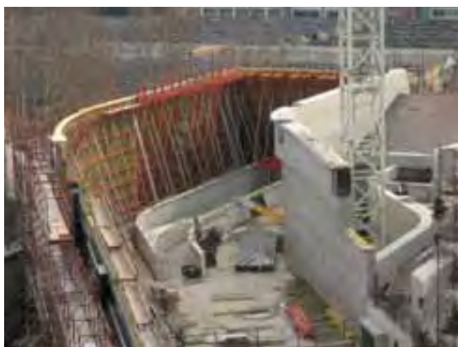
Fasi di scasseratura delle pareti
