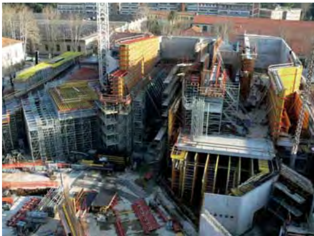
Veduta panoramica del cantiere durante la realizzazione delle pareti in cls a faccia vista
