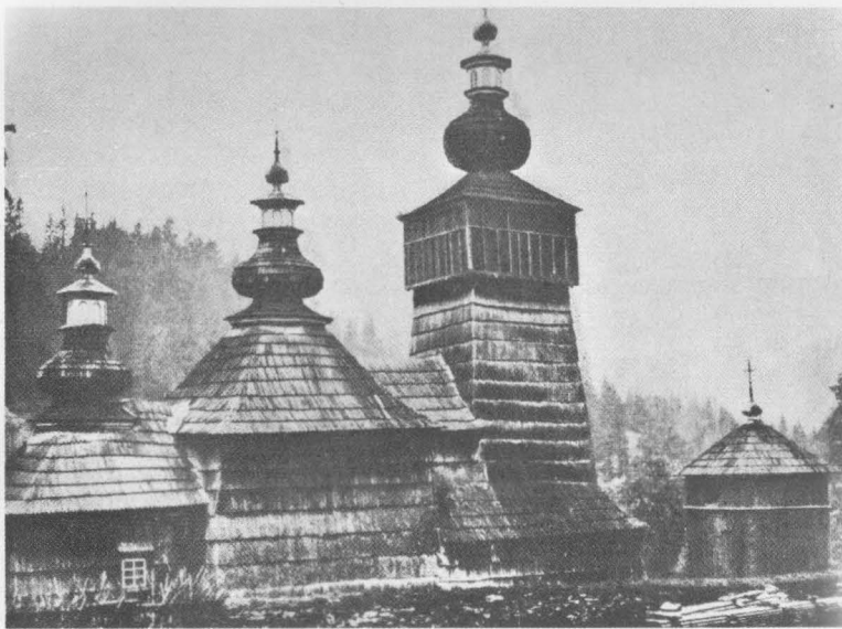
57. Чертижне (пов. Грибів), церква св. Михаїла. Пол. 18 ст. Знищена. Czertyzne, 18 c. Demolished.
