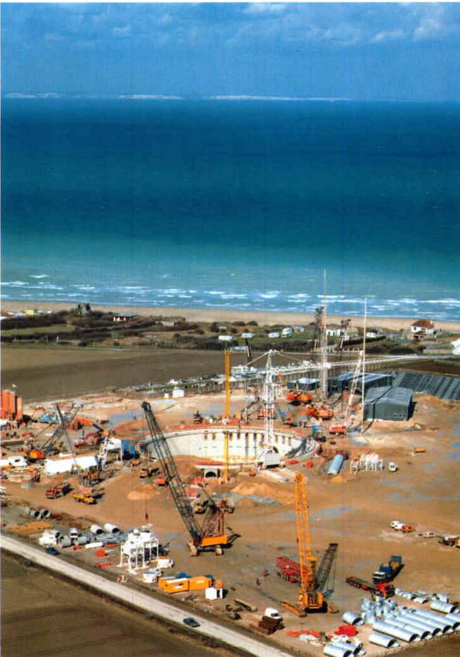
PUITS DE SANGATTE - ETAT DES TRAVAUX EN MARS 1987
