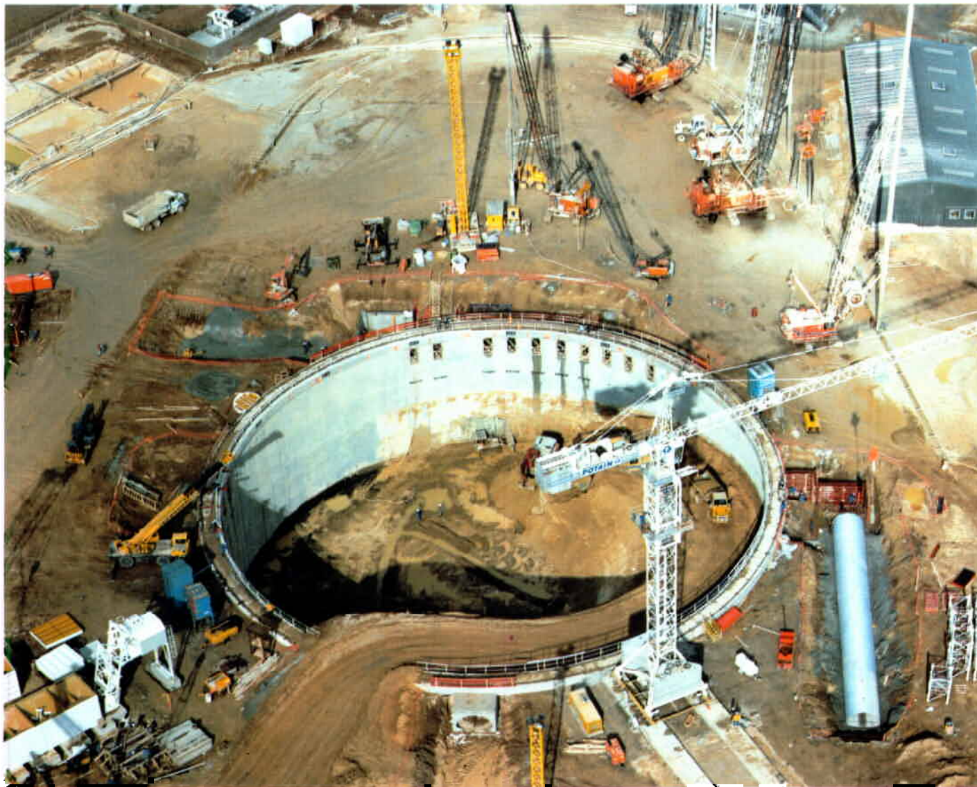
EXECUTION DE LA PAROI D'ETANCHEITE COTE NORD — TERRASSEMENT DU PUIS CIRCULAIRE — PAROI HYDROFRAISE
