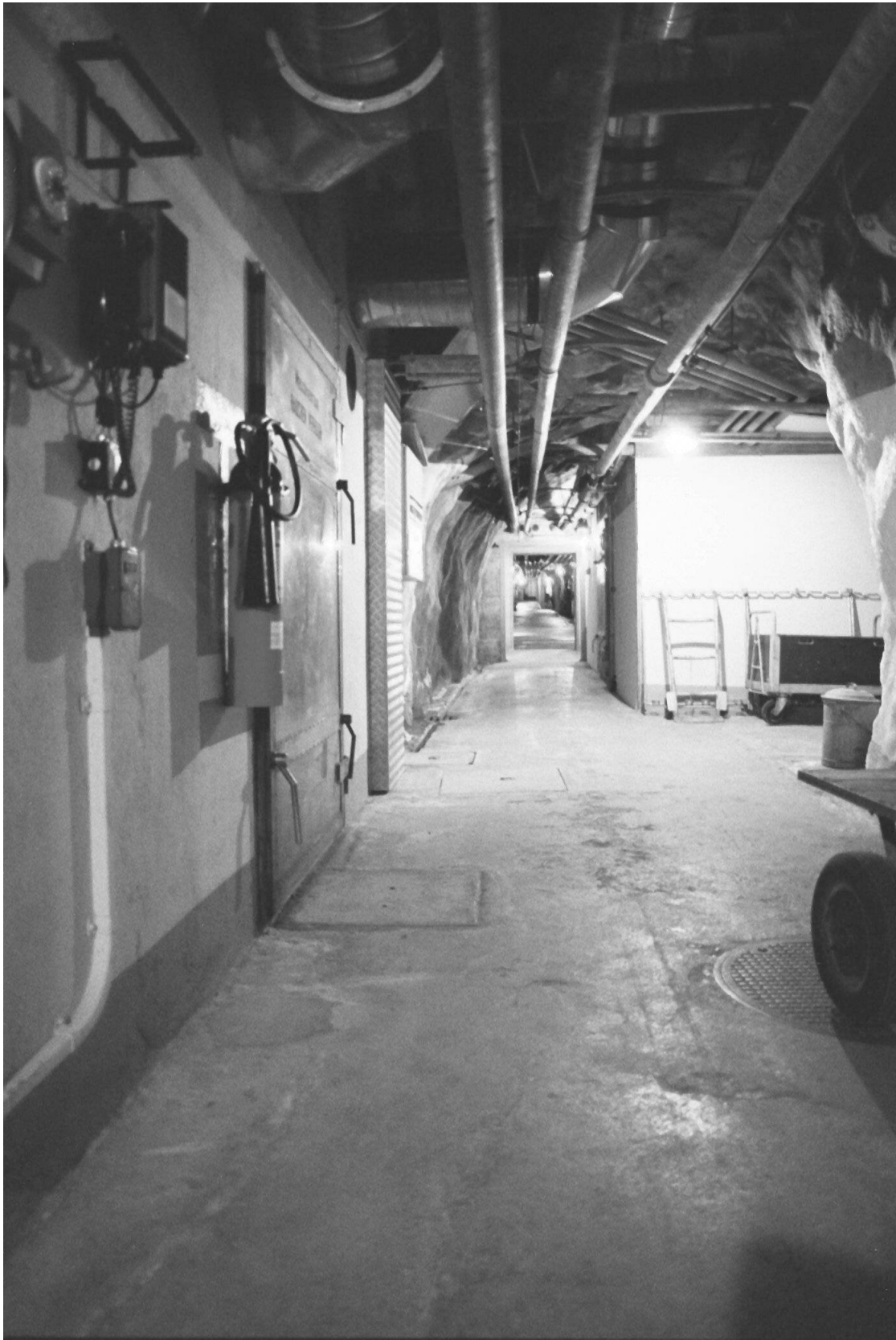
Abbildung 58: Im Hauptstollen beim Motorenraum
