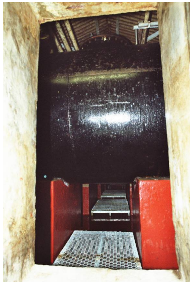
Abbildung 33: Blick in den Tankraum
