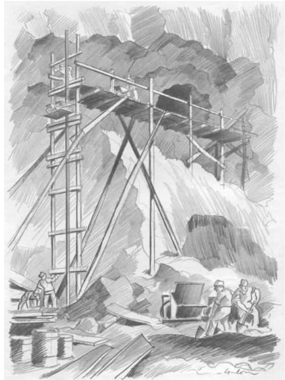
Abbildung 5: Arbeiten an einem Felswerk
