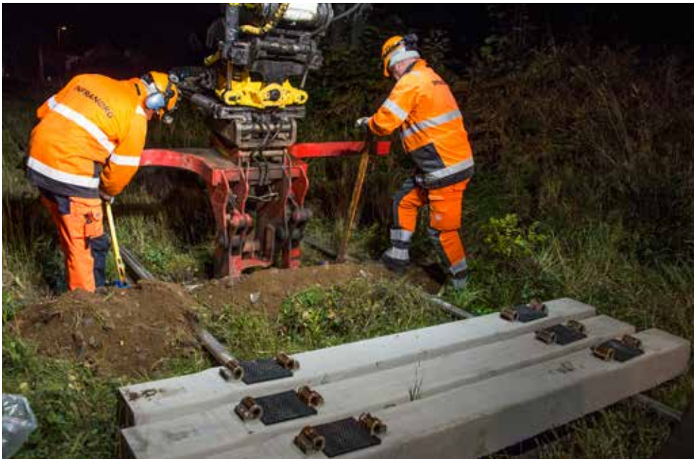
Kan de här betongsliparna i fortsättningen ersätta sliprar som är impregnerade med kreosot? Tester pågår i Småland, här vid Norrahammar. FOTO: KERSTIN ERICSSON
