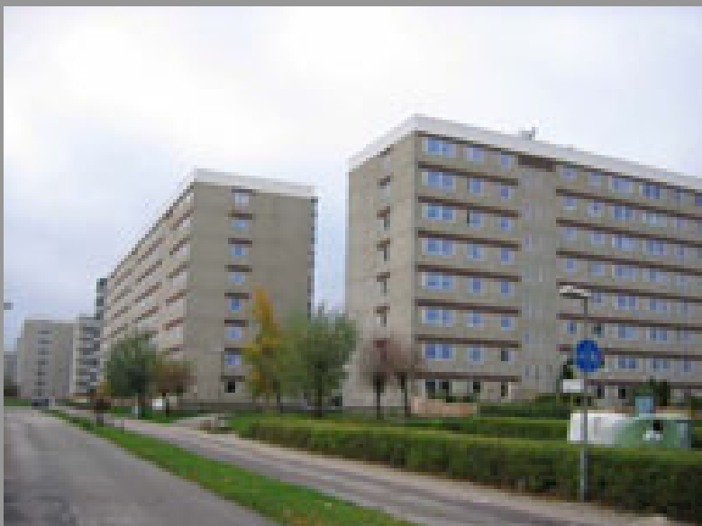
Skivhus i åtta våningar – Lindeborg, Malmö. Foto: J. Kignell och S. Lager, oktober 2005.
