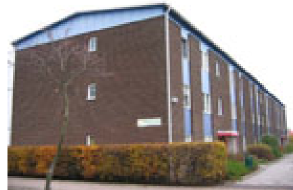
Lamellhus i tre våningar – Holma, Malmö. Foto: J. Kignell och S. Lager, november 2005.
