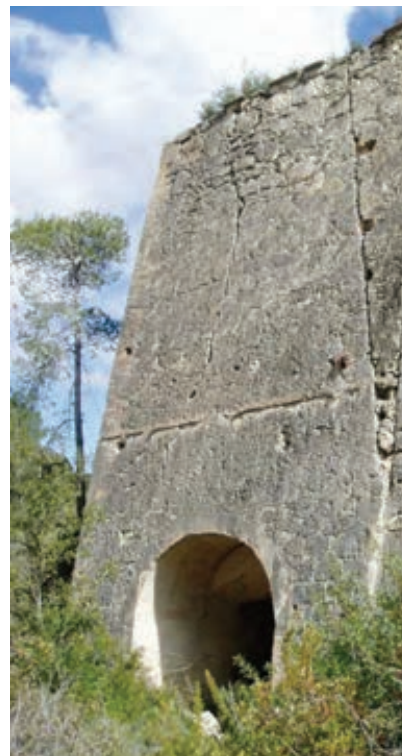
Forn de calç de Can Castellví (Olèrdola)
