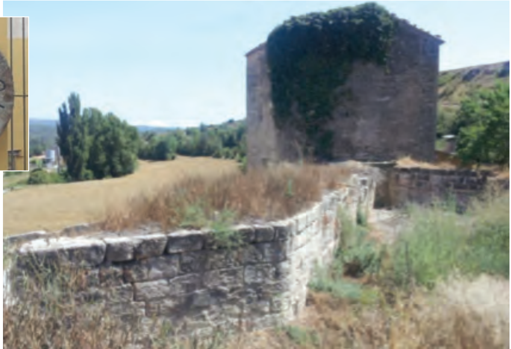
Molí de la Torre a Santa Coloma de Queralt, a la Conca de Barberà. Cos d'Agents Rurals. 2012. En primer pla, la bassa i el cub o cacau annexat a l'edifici del molí.
