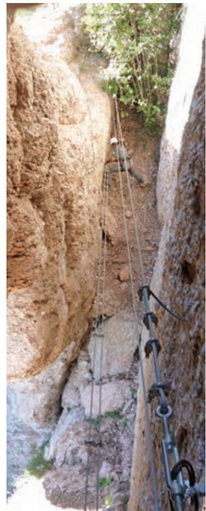
Desmuntatge d'una instal·lació.
