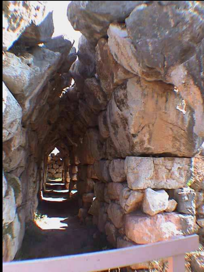
TIRINTO, GALLERIA COPERTA
