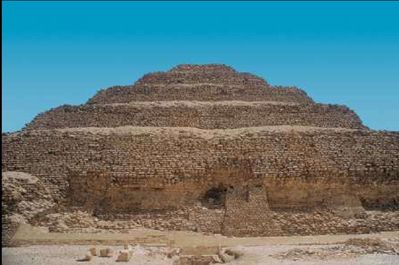
Saqqara, piramide di Zoser. In basso, i crolli del rivestimento rende visibile il nucleo della struttura interna
