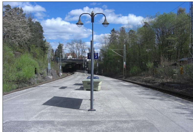
Foto 7: Plattformen på Blommenholm. Høydeforskjellen tatt opp med trinn og markert med rekkverk ses i enden av plattformen. Gul sperrelinje synes så vidt.
