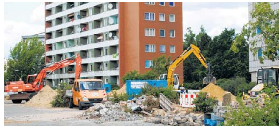
Auf dem ehemaligen Parkplatz an der Westerwaldstraße wird bereits emsig gebaut. Dort soll ein neuer Supermarkt entstehen. Foto: Ulrike Kiefert
