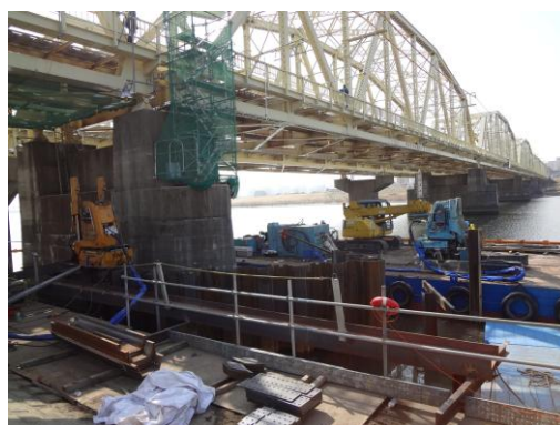
橋脚基礎の耐震補強工事（施工中） (東武スカイツリーライン北千住～小菅間 荒川橋梁)
