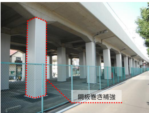
高架橋の耐震補強工事 (東武スカイツリーライン谷塚～草加間)
