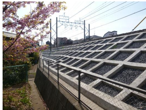
法面補強工事 (東上線東武練馬～下赤塚間)
