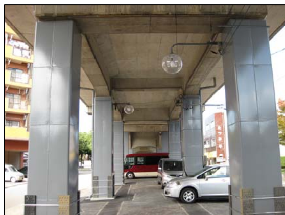
高架橋柱耐震補強 ※イメージ
