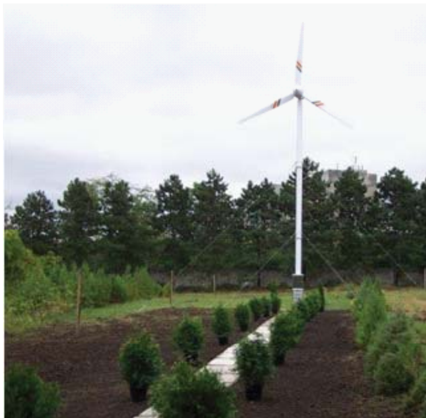
Fig.6. Turbină eoliană cu puterea de 10 kW instalată în Grădina Botanică a AȘM
