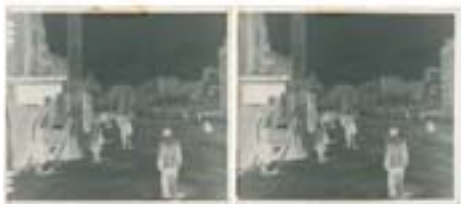
Negatiu estereoscòpic de gelatina sobre vidre. 7,9 x 8,9 cm 1909. Josep Oriol Borràs Obres d'enderrocament per l'obertura de la Via Laietana
