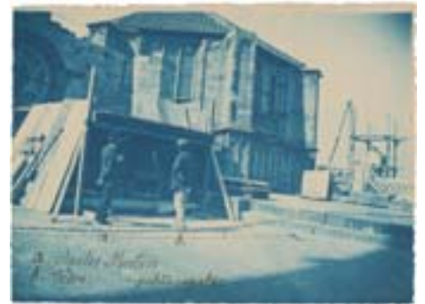
Cianotípia. 12,1 x 16,1 cm 1890. Autor desconegut Construcció del cimbori de la Catedral
