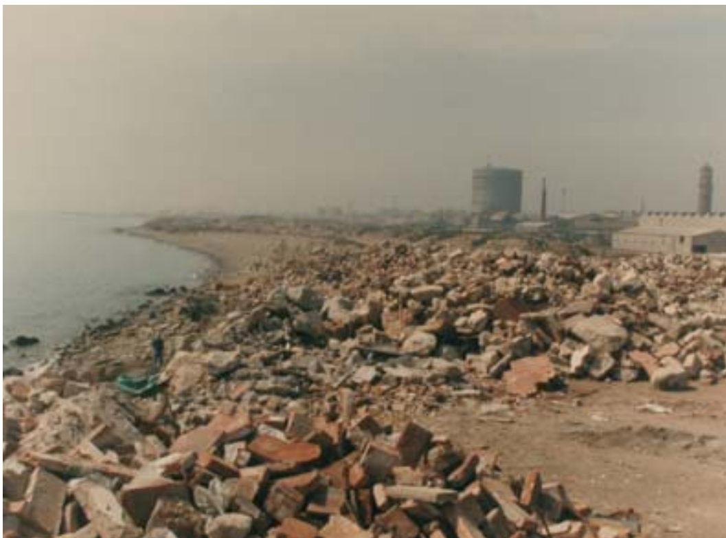
Positiu de color cromogen. 17,7 x 23,9 cm. 1988. Martí Llorens. Platges durant la construcció de la Vila Olímpica
