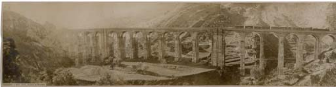
Positiu a l'albúmina. 23,5 x 94,5 cm. c.1870. Jean Laurent. Vista panoràmica del viaducte de Buxadell
