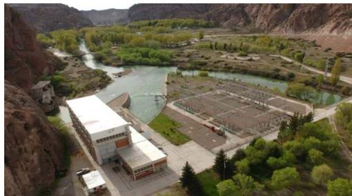
Está compuesto por una presa de hormigón y un edificio de máquinas.
