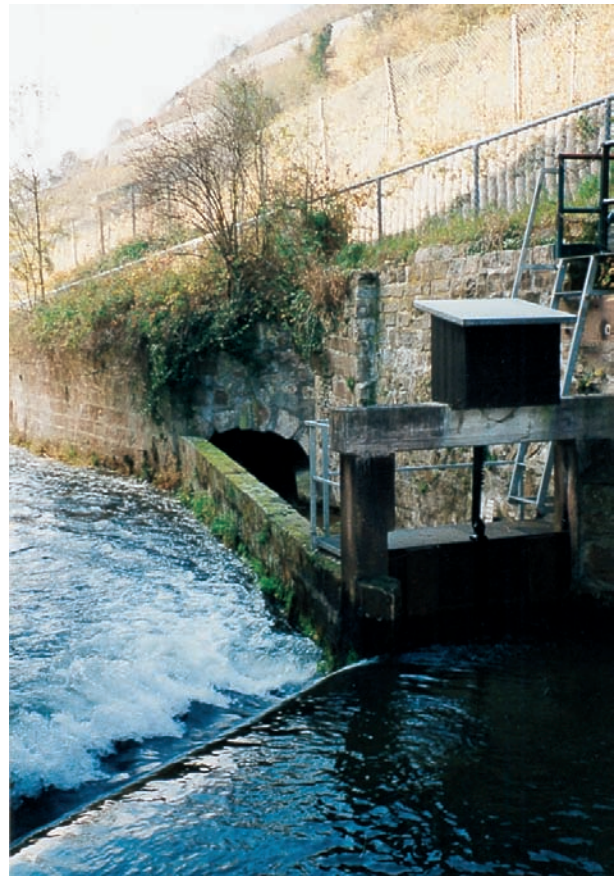
Abb. 28: Abzweigung des Bächlekanals vom Gewerbekanal und Eingang in den Bächlestollen hinter dem Gebäude Kartäuserstraße 47a
