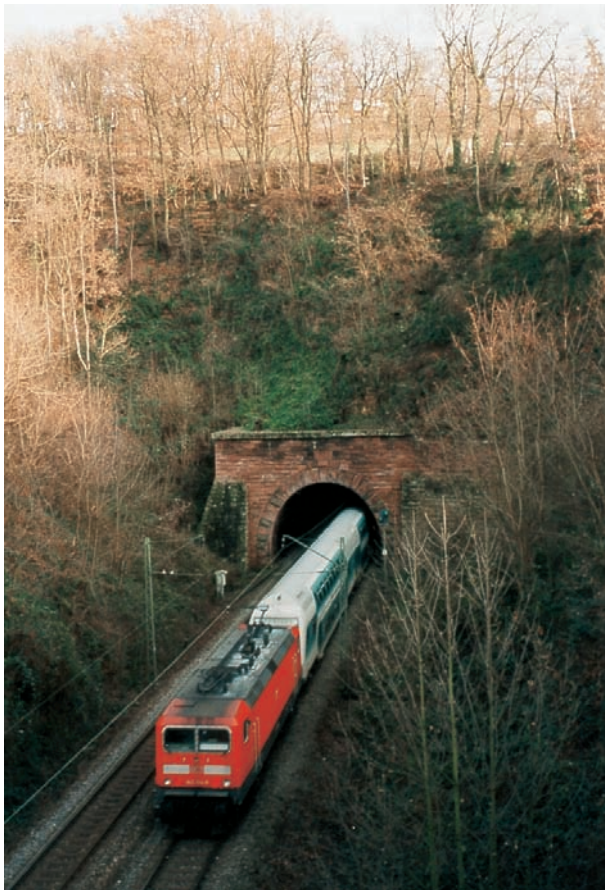
Abb. 3: Mittelalterlicher Steinbruch am Schlierberg mit Westportal des Loretotunnels (Höllentalbahn)
