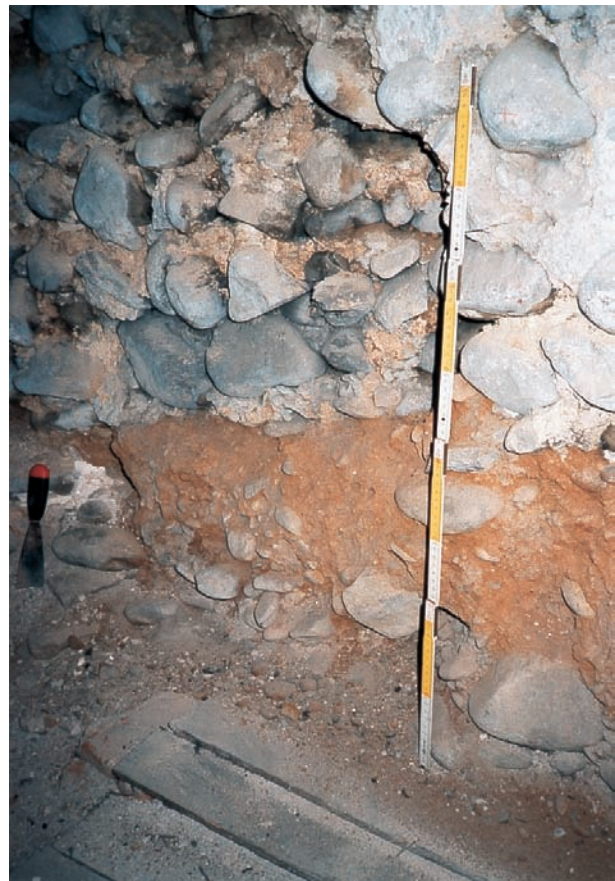
Abb. 9: Übergang des Niederterrassenschotters (unten) in die darüber folgende verwitterte lehmige Decklage im Keller des Gebäudes Oberlinden 14 in Freiburg i. Br.
