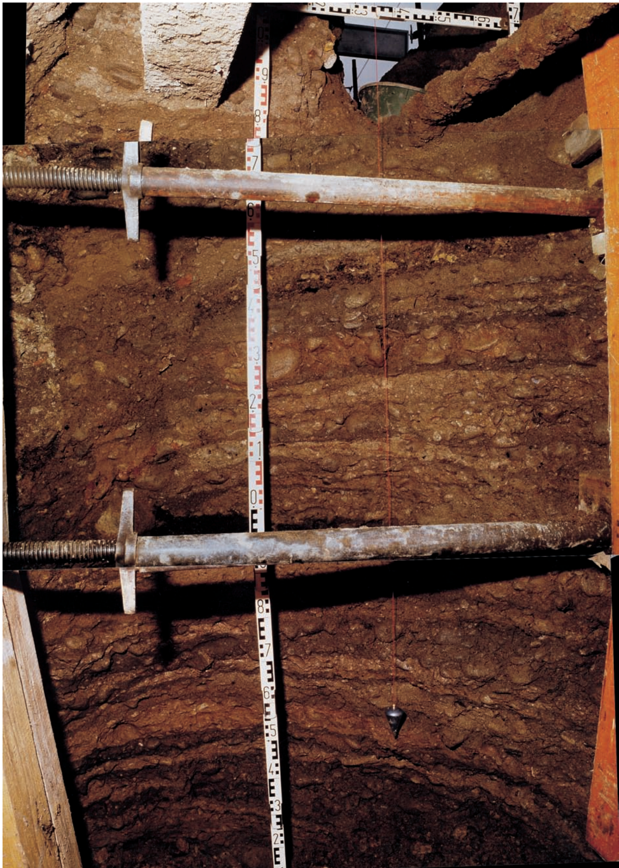
Abb. 27: Straßenaufschüttung in der Salzstraße
