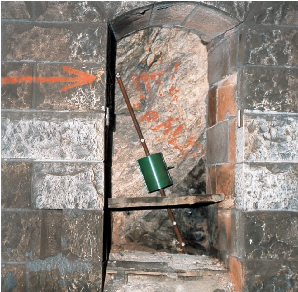
Abb. 14: Östliche Hauptverwerfung des Oberrheingrabens im Lorettotunnel der Höllentalbahn
