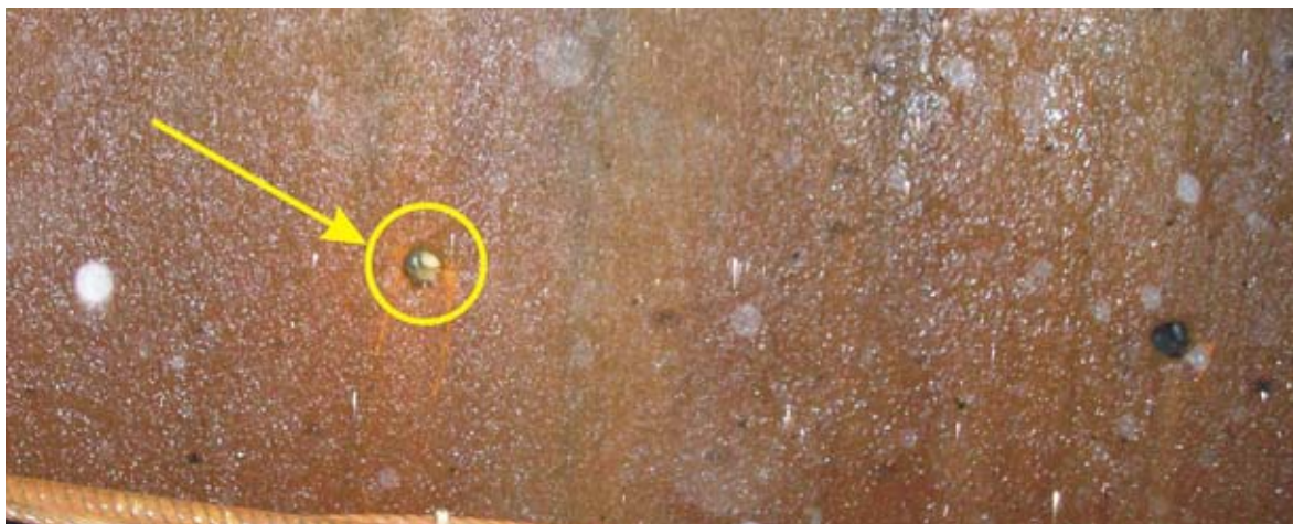
Рис. 4. Появление смолы при нагнетании в соседние шпуры.
