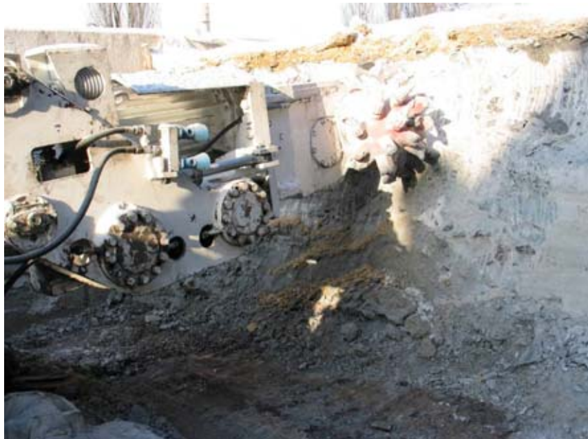
Рис. 4. Проходческий комбайн КПЛ на пороцементном блоке
