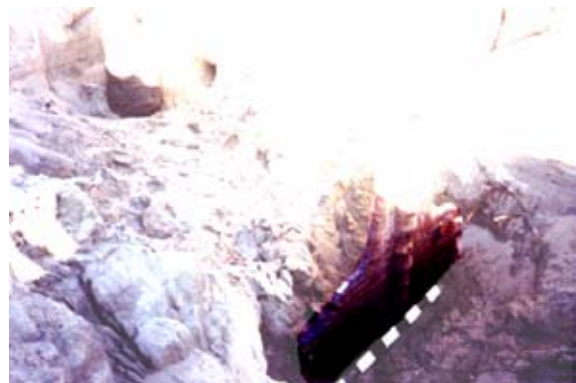
Рис. 7. Закрепленные с помощью струйной технологии растворо-породные элементы: а) с вращением струйного монитора; б) без вращения струйного монитора.
