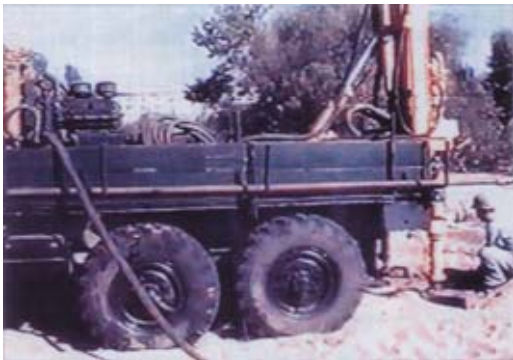
Рис. 6. Установка для струйного закрепления пород.
