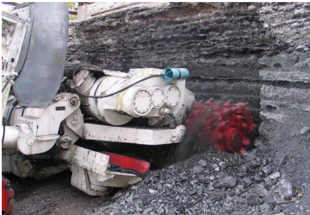
Рис. 6. Проходческо-анкероувальный комплекс КПА на углепородоцементном блоке.
