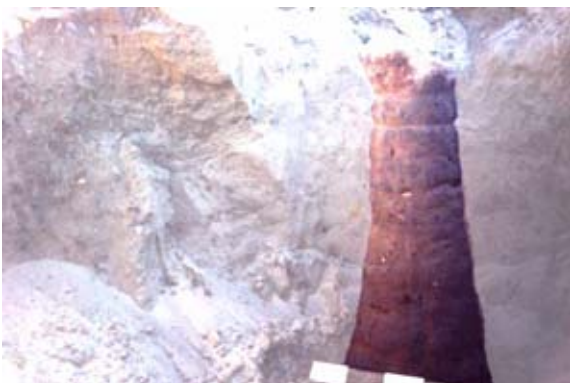
Рис. 7. Закрепленные с помощью струйной технологии растворо-породные элементы: а) с вращением струйного монитора; б) без вращения струйного монитора.
