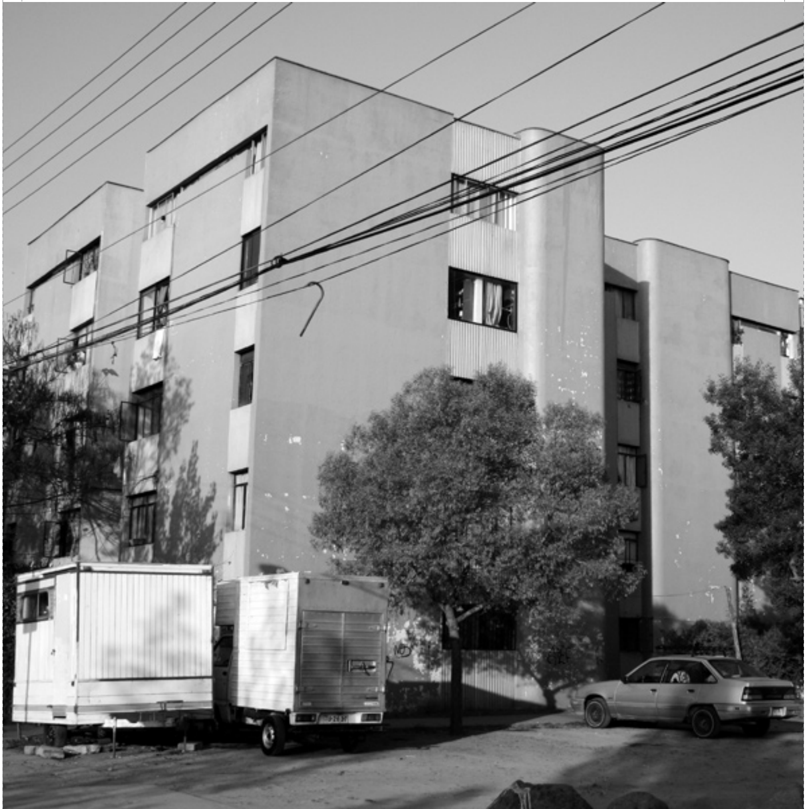
Uno de los «blocks» actualmente habitados de la Villa San Luis. En términos de su arquitectura el conjunto enfatiza su carácter masivo, para ellos recurre a una tipología de bloque de media altura (5 pisos) y gran longitud. Foto de Claudio Pulgar, 2008.
