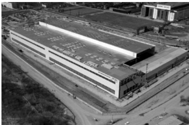
Рисунок 3. Строительство блока корпусных производств ОАО «ДВЗ «Звезда»
