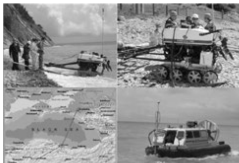
Рисунок 9. Выполнение работ на прибрежных участках газопровода «Голубой Поток»
