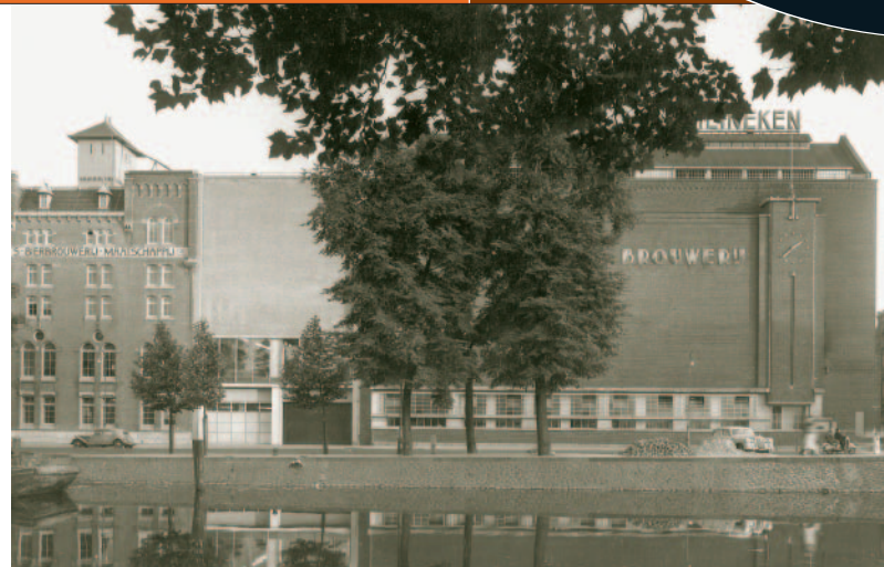
Het Heineken-kantoor in Amsterdam is er één in een lange reeks van opdrachten voor de bierbrouwer. / Foto: DHV.
