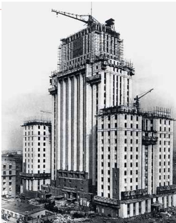
Строительство здания МИДа
